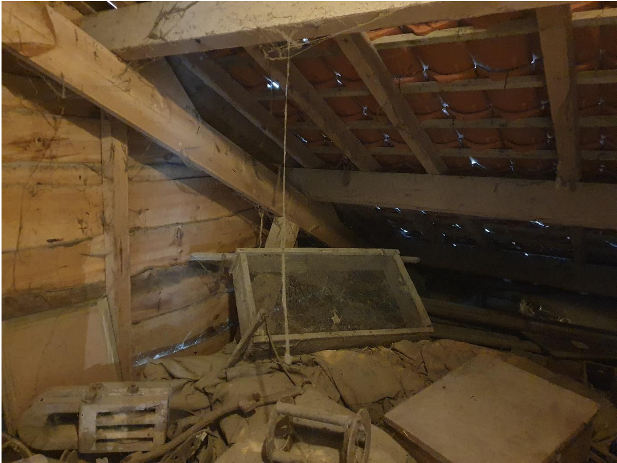
Fig. 138: Overzicht van ruimte 1.3.
