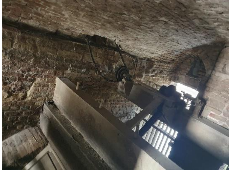
Fig. 103: De sluisdeur is schuin geplaatst (links) en kan open en dicht gezet worden met de ketting die door het gewelf steekt (rechts).
