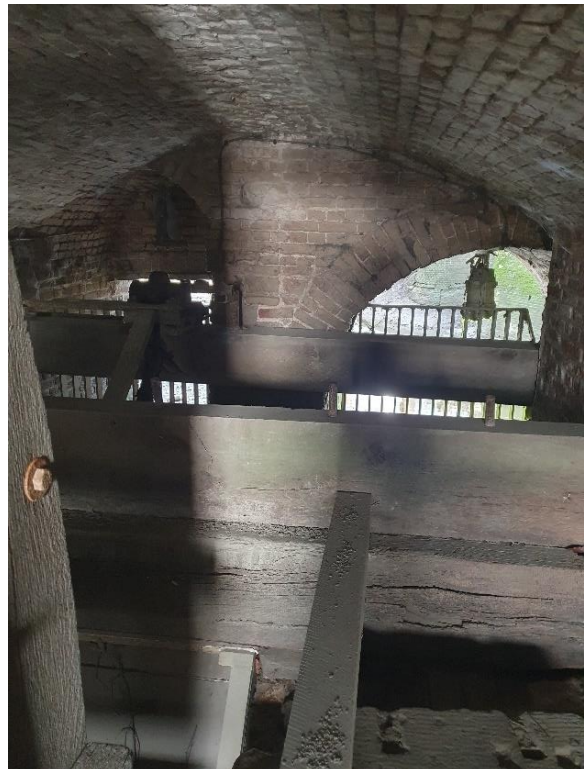
Fig. 102: Via het onderste niveau, bereikbaar met houten steektrapje, is de achterzijde van beide maalsluizen te zien, gevat onder een bakstenen gewelf.
