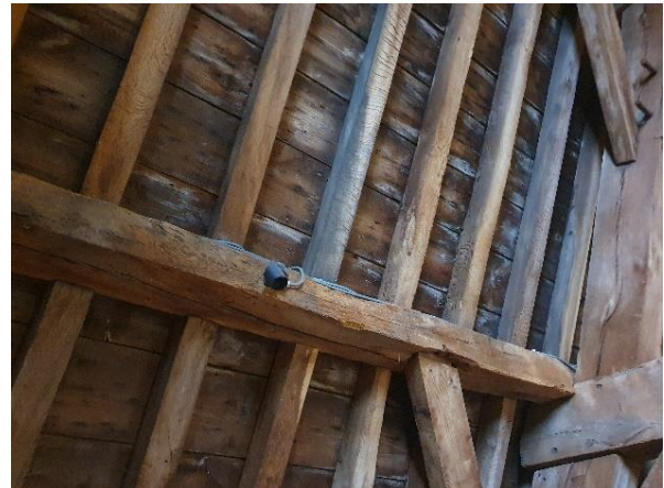
Fig. 145: Verschil tussen de onderste gording die de helling van het dak volgt (links) en de flieringen die de richting van de dekbalken volgen (rechts). Het gebruik van flieringen is ouder dan van gordingen, eens na de 16 de eeuw komt dit amper nog voor.
