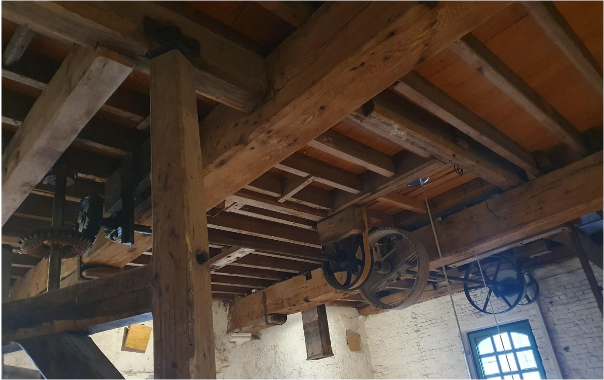
Fig. 131: Overzicht van het luiwiel en de secundaire balkenstructuur die aangebracht is.
