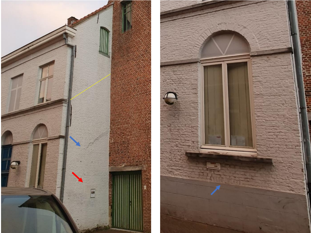
Fig. 87: Links: In de kopgevel zit een veelheid van bouwsporen. Bovenaan kan het schuine dak van het inkomvolume dat bij de restauratie werd afgebroken afgelezen worden. Daaronder is nog een schuin spoor te zien, maar met afwerking bovenaan met vlechtwerk (blauw), wat er op wijst dat dit een zeer oude muur is. Het muurdeel onder deze opening bestond dus al, het geveldeel daarboven werd later pas bovenop dit bestaande stuk geplaatst. In dit oude muurdeel is ook een dichtgemaakte deuropening te zien (rood). Rechts: In de borstwering van het venster in de laatste travee is de bovenzijde van een dichtgemaakte kelderopening te zien (blauw). Samen met de lage positie van het bouwspoor van het schuine dak daarnaast wijst dit er op dat hier oorspronkelijk vanbinnen een halfondergrondse ruimte moet geweest zijn, wat bevestigd wordt door de aanwezigheid van een trapje op het grondplan van 1776 (zie onder).
