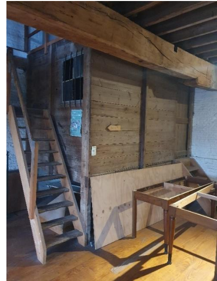
Fig. 125: De moerbalken hebben een ander type van sleutelbalken dan bij ruimte 0.5 aanwezig zijn, wat een aanwijzing kan zijn dat deze balken niet tijdens dezelfde periode geplaatst werden. In de archiefdocumenten werd melding gemaakt van een houten roostering die in 1673 vervangen werd (links). In de hoek staat een houten hok waar de molenaar of knecht tijdens de nachtshift kon verblijven. Afgaande op de jaartallen die op het krantenpapier aangetroffen worden waarmee de binnenkant beplakt is, is dit hok niet later dan de jaren 1860 opgebouwd (rechts).
