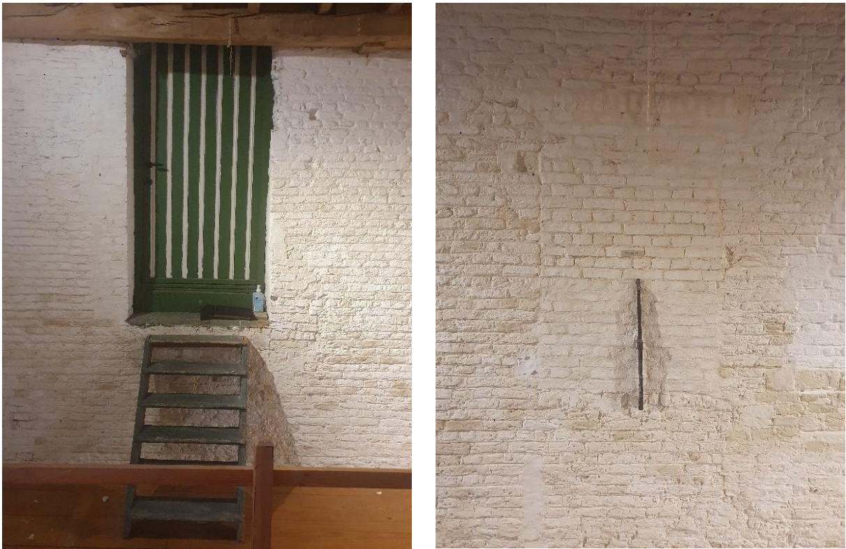
Fig. 134: In de oostgevel een recent deurtje naar de stalzolder (links) en een venster dat dichtgemaakt werd bij aanbouw van de stal (rechts).
