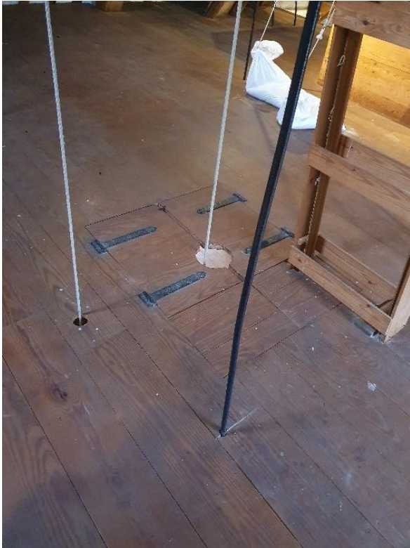
Fig. 142: Luik voor het luiwerk en op de voorgrond een ijzeren trekstaaf om de onderliggende moerbalk aan op te hangen (links). Houten trechter naar de onderliggende kaar (rechts).
