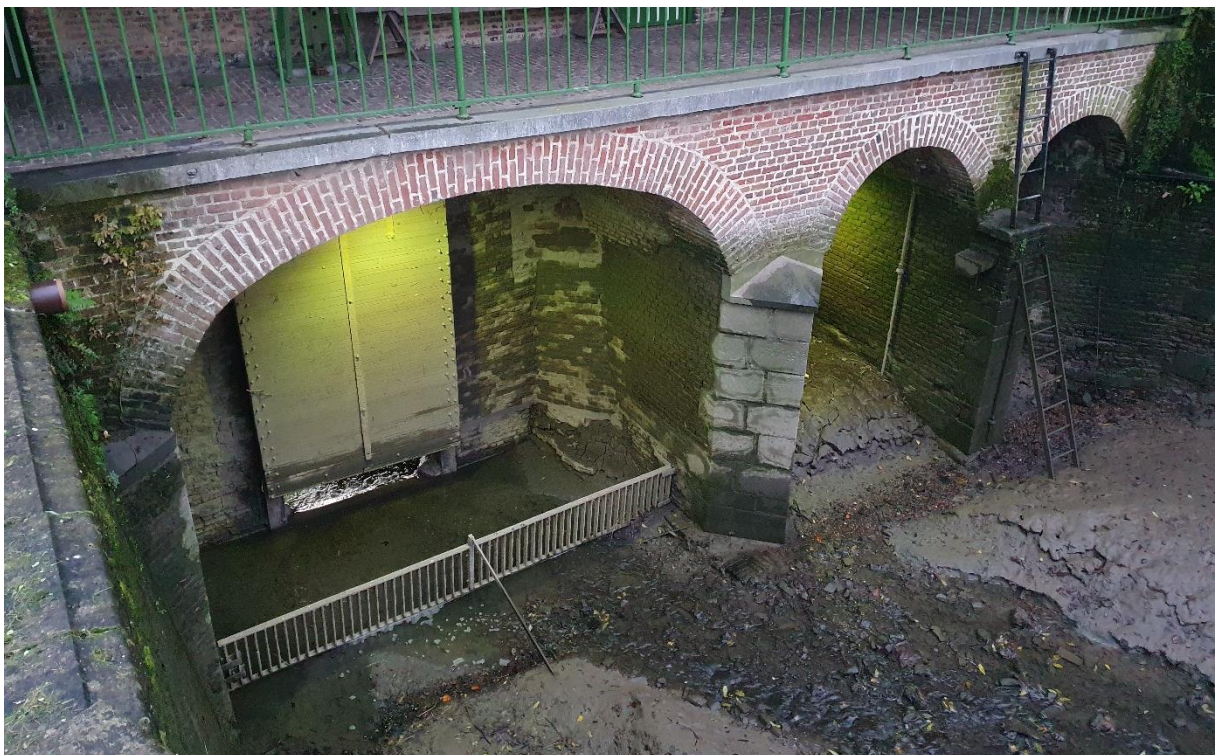
Fig. 83: Onderzijde van de noordzijde. Op de natuursteenblokken zijn steenkappersmerken aanwezig die op een 18 de -eeuwse datering uit Ecaussines wijzen. Het baksteenmetselwerk daarboven werd zo goed als volledig tijdens een ingrijpende restauratie van de jaren 1980 heropgebouwd.
