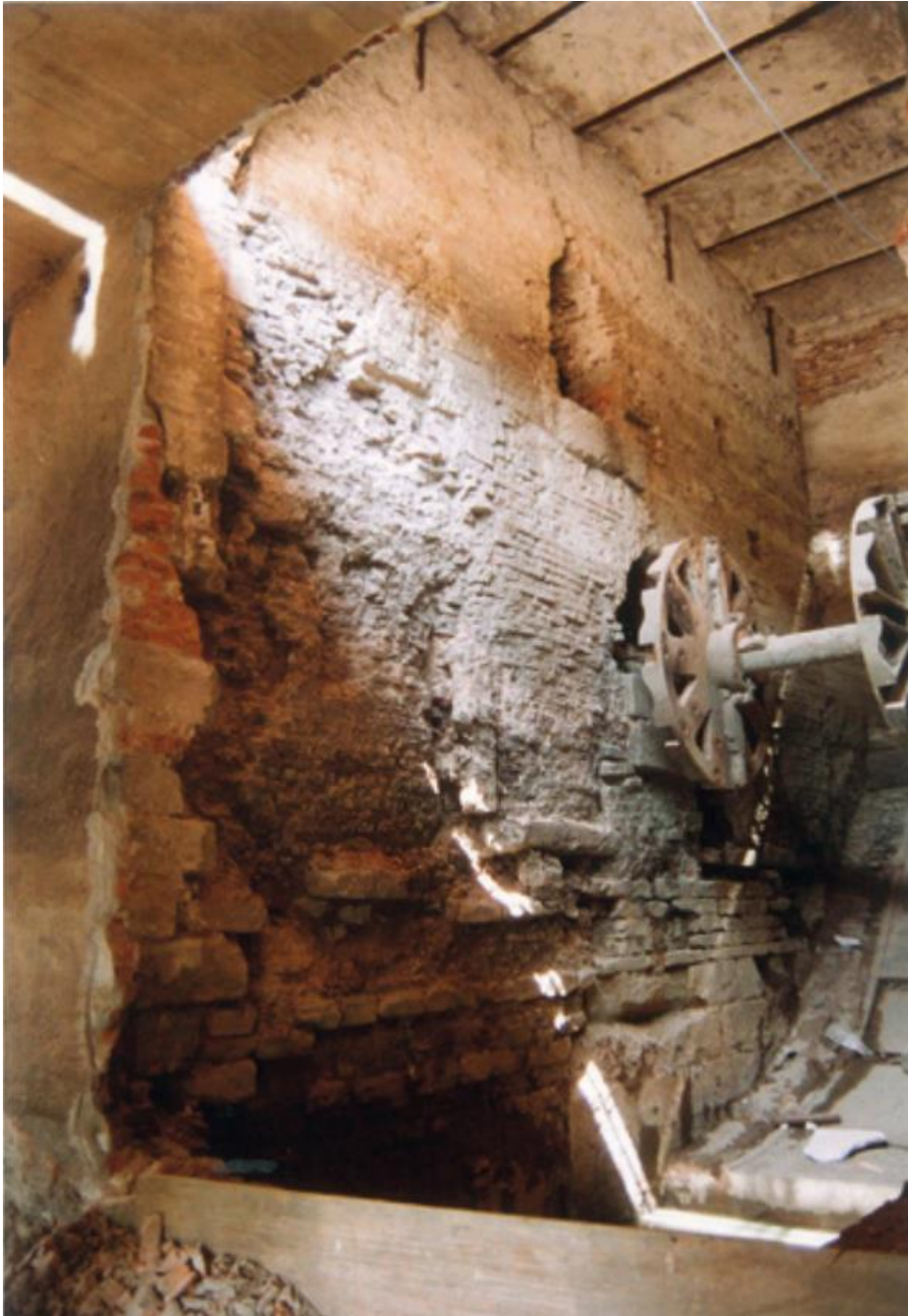
Fig. 43: Van het grote Ponceletwaterrad waren voor de restauratie enkel de metalen as en kerndelen bewaard, zoals dit zicht aan de binnkant van de maalsluis aantoon. (Kevin Poschet)
