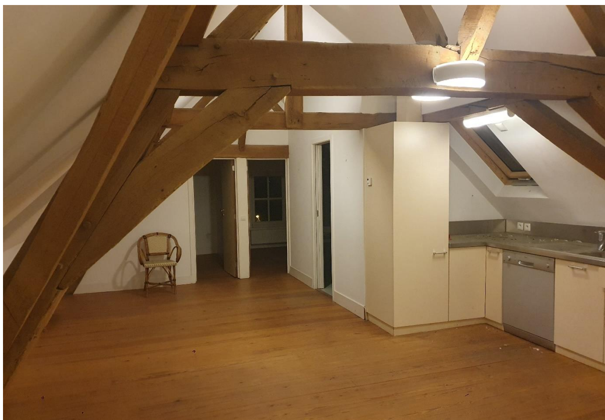
Fig. 170: Overzicht van ruimte 2.3.
