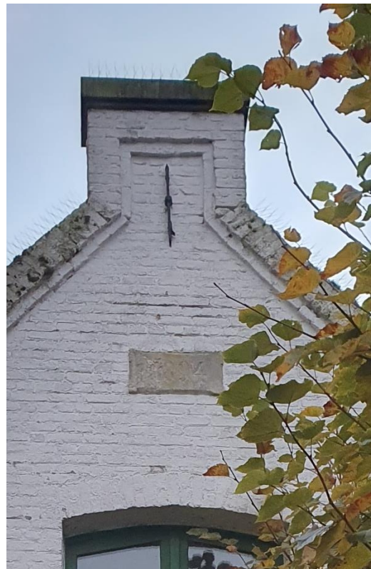
Fig. 91: Poorttravee langs de straat, er zijn geen sporen van een verwijderde hijsbalk te zien (links). In de tuitgevel is een jaarsteen met '1894' aangebracht (rechts).
