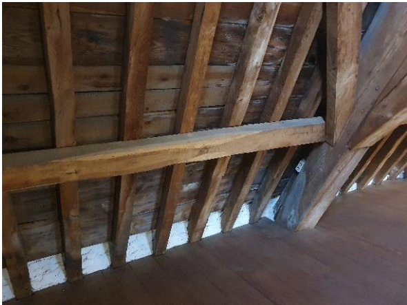
Fig. 145: Verschil tussen de onderste gording die de helling van het dak volgt (links) en de flieringen die de richting van de dekbalken volgen (rechts). Het gebruik van flieringen is ouder dan van gordingen, eens na de 16 de eeuw komt dit amper nog voor.
