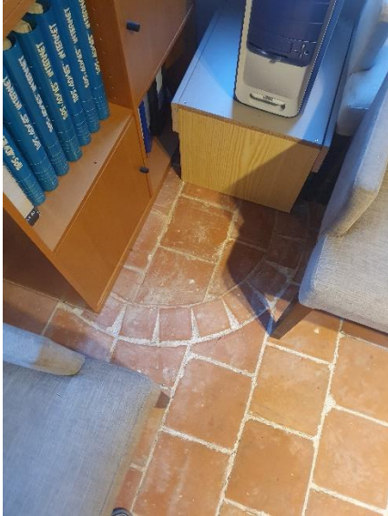
Fig. 156: Bij de restauratie werd beslist om bij het leggen van nieuwe vloeren de bestaande bouwsporen te hernemen. Het ronde dichtgemaakte gat zal te maken hebben met de voormalige keukenfunctie van deze ruimte (links). Sobere houten schouwmantels in de kamers (rechts).
