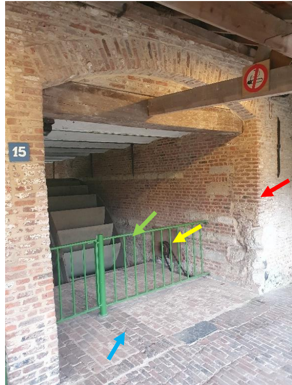
Fig. 99: Links: Bij de oprichting van de aanbouw van de molenaarswoning werd dit venster (blauw) dichtgemaakt en het muurgedeelte rechts ervan opengemaakt tot deuropening. Rechts: Bij de overgang tussen de twee baksteenvloertypes van ruimte 0.1 en 0.2 is in het vloerpatroon de aftekening van het rad aangeduid (blauw). Aan de dagkanten van de opening kan afgelezen worden dat deze oorspronkelijk lager was, of zelfs helemaal dicht (rood). De rest van de wand is een oninterpreteerbaar lappendeken van bouwsporen, hierin kan wel nog het ophaalsysteem van de sluisdeur (geel) en de bovenzijde van een dichtgemaakt venster (groen) gezien worden. Dit venster zou er op wijzen dat het vloerniveau van ruimte 0.4 oorspronkelijk veel lager lag.
