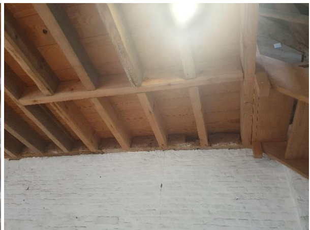
Fig. 137: Inkepingen van een verdwenen standvink bij een van de moerbalken (links). Naast het zoldertrapje kan aan de raveel het voormalige trapgat afgelezen worden (rechts).
