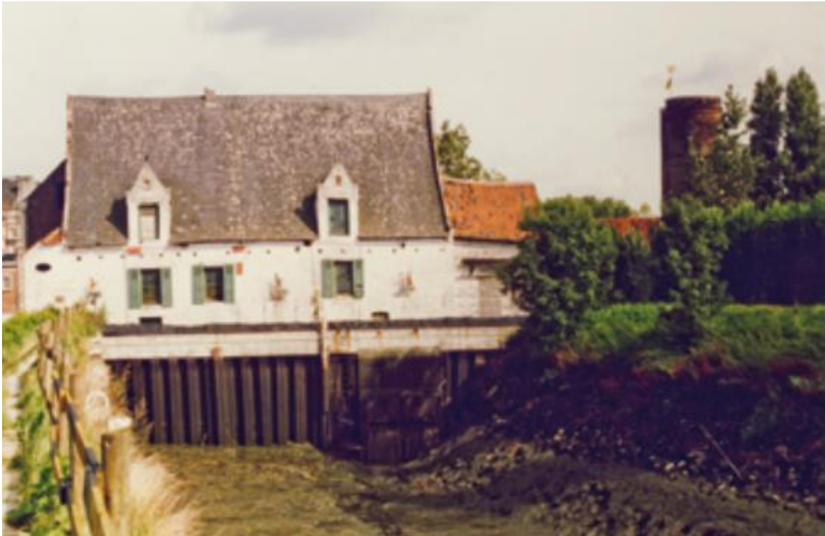
Fig. 34: Voor de restauratie zat het volledig wit gekaleide gebouw half verscholen achter een metershoge stalen kofferdam met sluis. Links was voor de ingang van de molen een portiek aangebouwd, rechts zijn nog de pannendaken van de oude stallen zichtbaar met daarachter de Graventoren.
