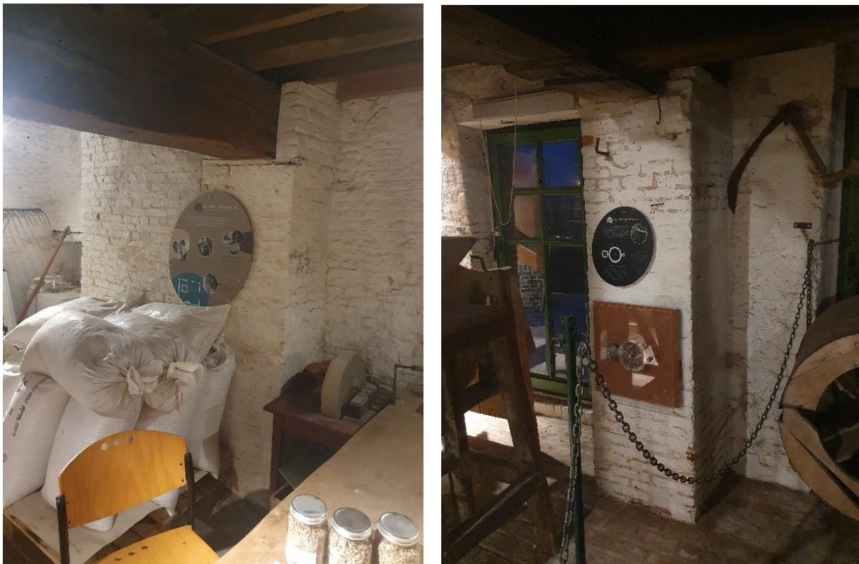
Fig. 106: De westelijke moerbalk is langs beide zijden opgelegd in bakstenen steunberen die tegen de wanden zijn aangebracht, volgens Kevin Poschet zou dit zijn omdat het bestaande metselwerk niet draagkrachtig genoeg meer was na de brand van 1567.
