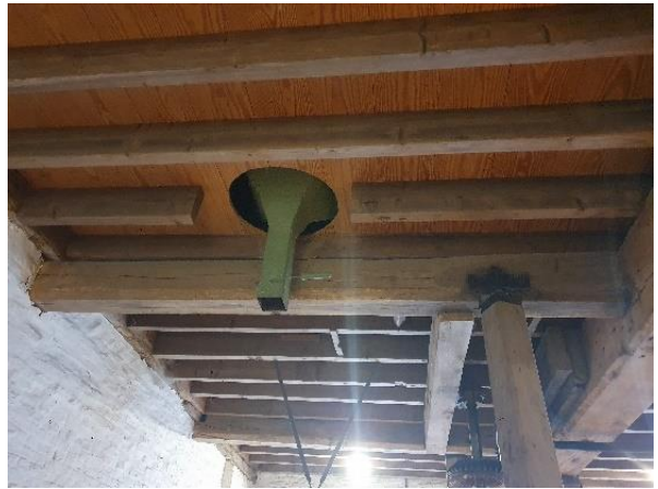
Fig. 130: Trechters in de plafond waarlangs het graan in de onderliggende karen werd gestort, er zijn slechts twee van de vier nog aanwezig, en elk van een ander type.
