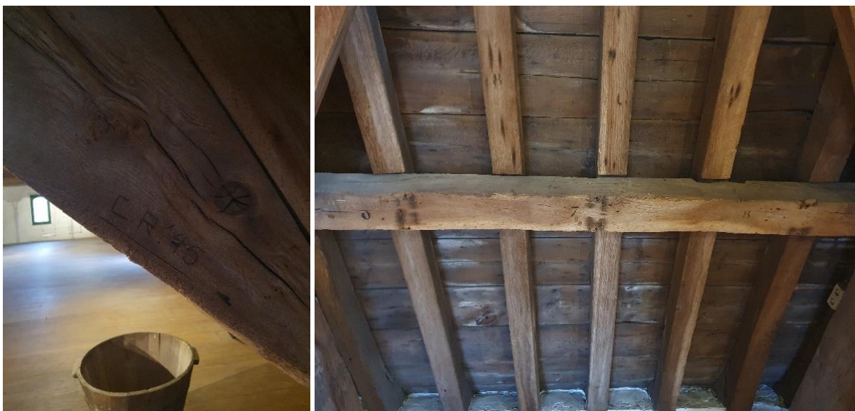
Fig. 146: Op de balken is historische graffiti aanwezig, zoals "C.R. '45", mogelijk een verwijzing naar het einde van WO II (links) en cijfers die gebruikt werden voor de opslagfunctie van de ruimte (rechts).
