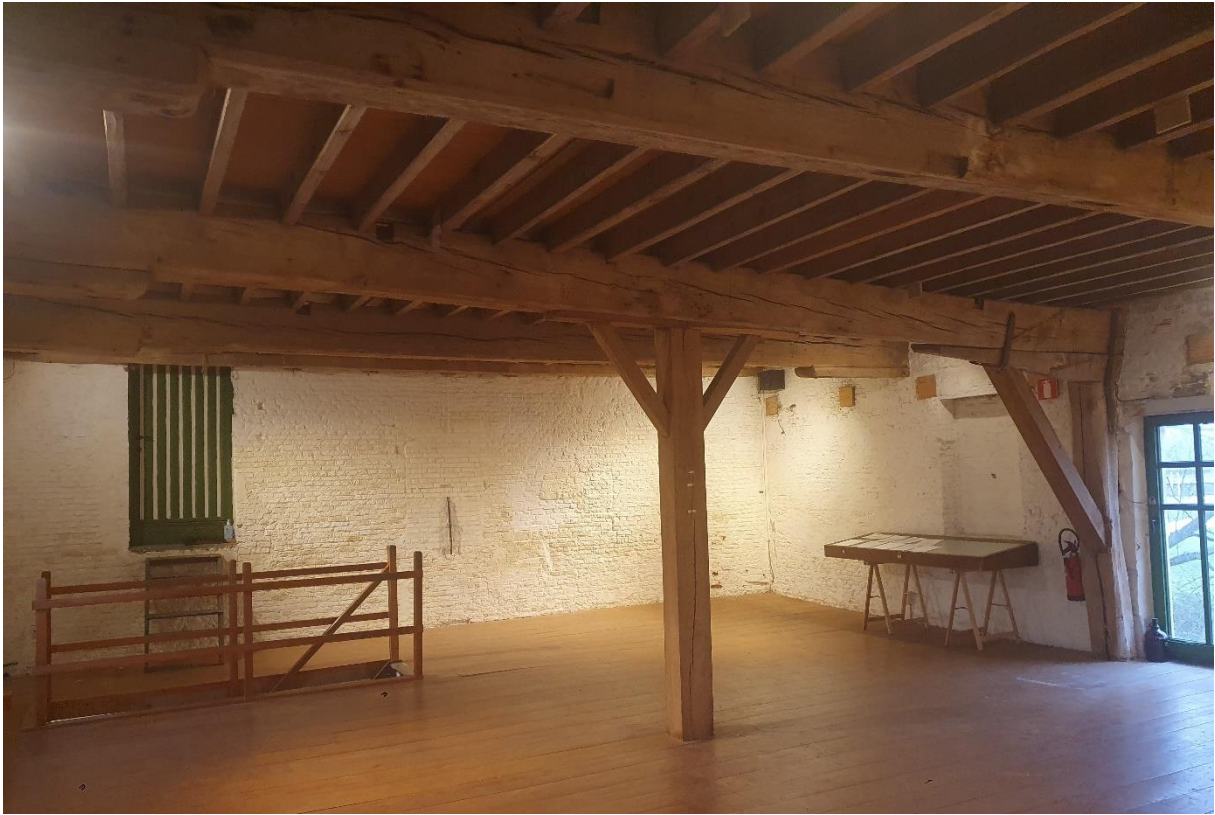
Fig. 132: Overzicht van ruimte 1.2.
