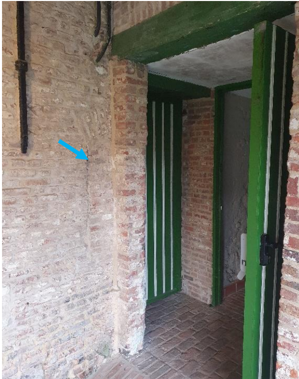
Fig. 99: Links: Bij de oprichting van de aanbouw van de molenaarswoning werd dit venster (blauw) dichtgemaakt en het muurgedeelte rechts ervan opengemaakt tot deuropening. Rechts: Bij de overgang tussen de twee baksteenvloertypes van ruimte 0.1 en 0.2 is in het vloerpatroon de aftekening van het rad aangeduid (blauw). Aan de dagkanten van de opening kan afgelezen worden dat deze oorspronkelijk lager was, of zelfs helemaal dicht (rood). De rest van de wand is een oninterpreteerbaar lappendeken van bouwsporen, hierin kan wel nog het ophaalsysteem van de sluisdeur (geel) en de bovenzijde van een dichtgemaakt venster (groen) gezien worden. Dit venster zou er op wijzen dat het vloerniveau van ruimte 0.4 oorspronkelijk veel lager lag.
