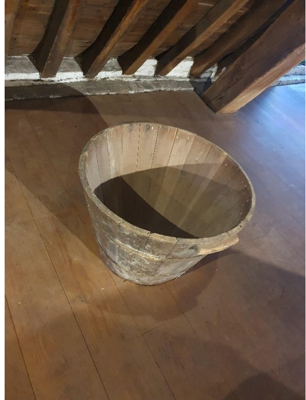
Fig. 142: Luik voor het luiwerk en op de voorgrond een ijzeren trekstaaf om de onderliggende moerbalk aan op te hangen (links). Houten trechter naar de onderliggende kaar (rechts).
