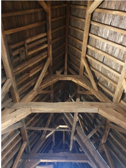
Fig. 144: Bovenzijde van de kapconstructie (links) en loefgaten in de onderste dekbalk die er op wijzen dat hier een vloeringvloer moet gezeten hebben. Deze sporen zijn enkel aanwezig tussen spanten II en III, ofwel was dit dus een plaatselijke vloer, ofwel werden de kinderbalken bij de andere spanten opgelegd in plaats van ingelooft (rechts).
