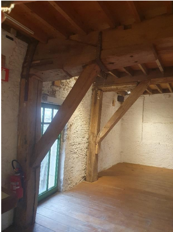
Fig. 136: Verstevingen aangebracht om de verzakking van de balkkoppen op te vangen.
