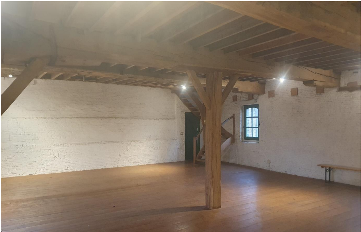
Fig. 133: Overzicht van ruimte 1.2.
