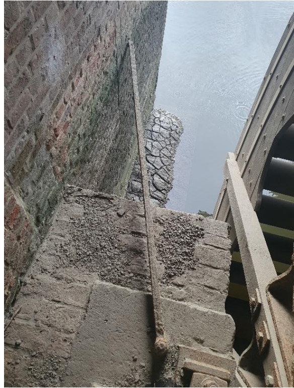
Fig. 101: De spil draait in een metalen schoen op een hardstenen kussenblok (links), vastgezet met trekankers (rechts).
