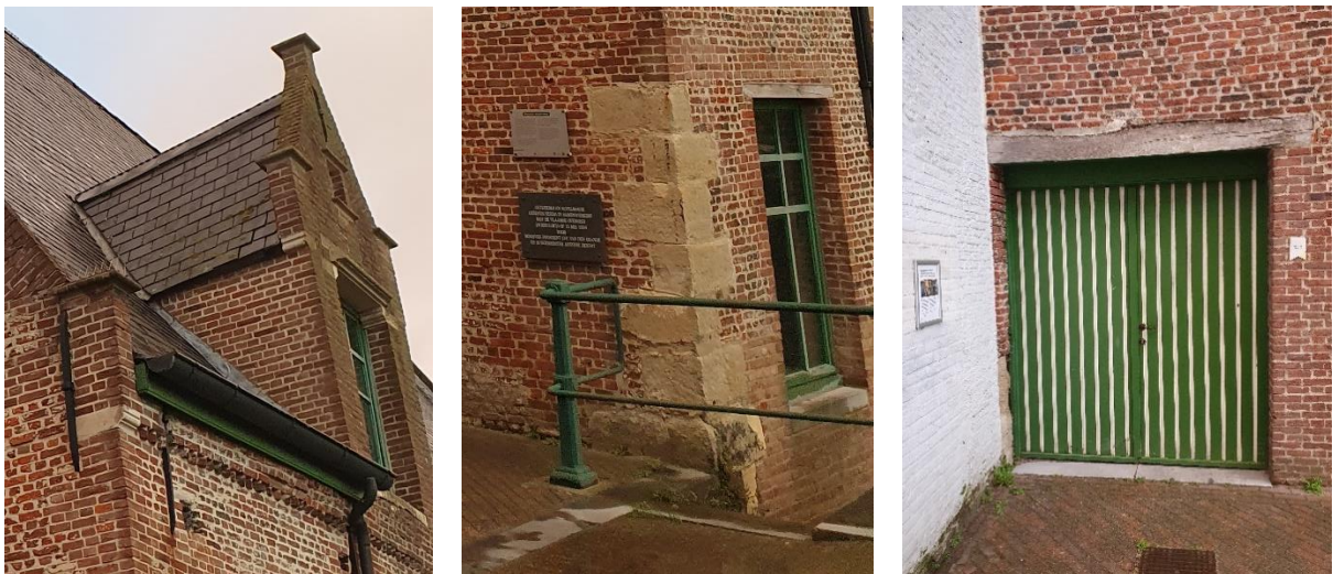
Fig. 81: Detail van het schouderstuk van de kopgevel met geprofileerde console, waarachter de zijkant van de dakkapel. De dakkapellen werden grotendeels heropgebouwd bij de restauratie (links). Het gedeelte met de hoekkettingen behoort nog tot de originele bebouwing, het metselwerk daarboven werd bij een verbouwing of herstelling pas opgericht (midden). Links van de poort in de westgevel zijn onderaan nog enkele witstenen negblokken aanwezig, wat er op wijst dat hier oorspronkelijk reeds een opening gezeten heeft. De huidige opening werd bij de restauratie aangepast, zichtbaar aan het afwijkende baksteenmetselwerk aan de rechtse dagkant. De groene(-witte) kleur werd bij de restauratie van de jaren 1990 uniform over al het buitenschrijnwerk aangebracht, deze kleuren werden destijds niet gekozen op basis van een historische kleurstelling (rechts).
