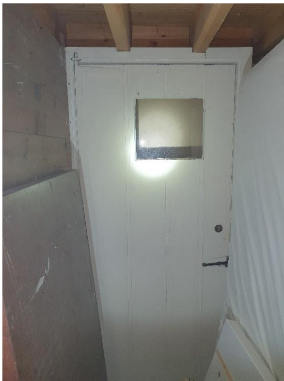
Fig. 126: In het hok is het enige historische schrijnwerk van het hele gebouw bewaard gebleven, waarbij een midden-19 de -eeuwse datering zeker kan kloppen. Het deurtje gaf uit op ruimte 1.5 van de molenaarswoning, maar de deuropening werd inmiddels dichtgemaakt. De doorgang naar ruimte 1.6 is wel nog functioneel, maar ingevuld met een nieuwe deur.
