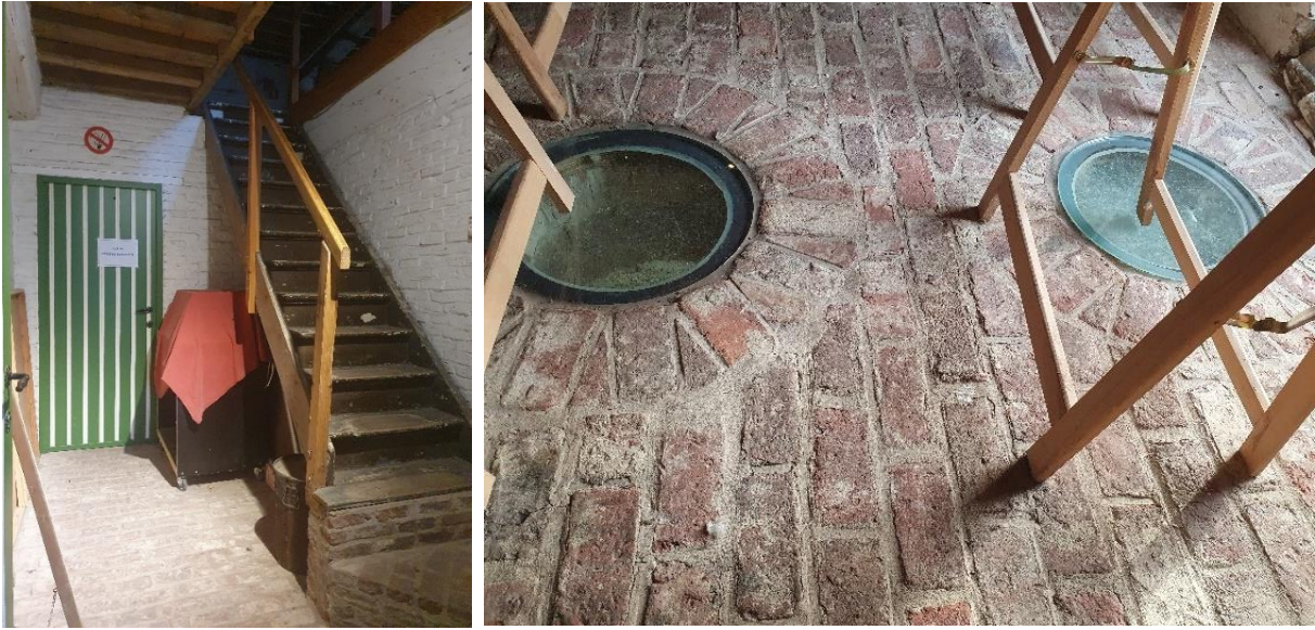
Fig. 117: De wanden van ruimte 0.6 zijn pas een latere toevoeging, het trapje werd bij de restauratie pas geplaatst, daarvoor zat dit aan de andere zijde van de ruimte (links). Kokers naar de vloedsluis ter hoogte van het venster (rechts).
