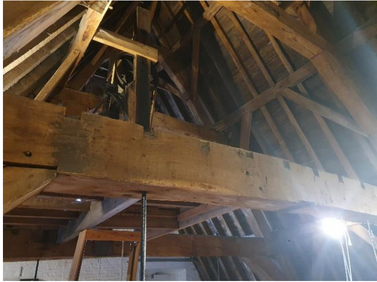
Fig. 144: Bovenzijde van de kapconstructie (links) en loefgaten in de onderste dekbalk die er op wijzen dat hier een vloeringvloer moet gezeten hebben. Deze sporen zijn enkel aanwezig tussen spanten II en III, ofwel was dit dus een plaatselijke vloer, ofwel werden de kinderbalken bij de andere spanten opgelegd in plaats van ingelooft (rechts).
