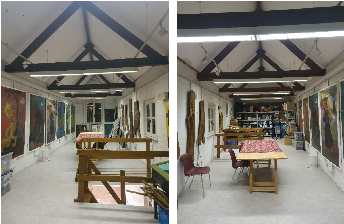
Fig. 179: Overzicht van de zolder.
