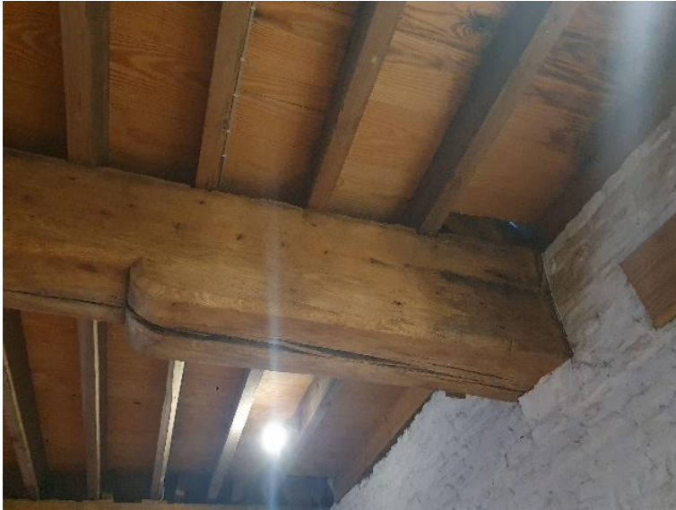
Fig. 125: De moerbalken hebben een ander type van sleutelbalken dan bij ruimte 0.5 aanwezig zijn, wat een aanwijzing kan zijn dat deze balken niet tijdens dezelfde periode geplaatst werden. In de archiefdocumenten werd melding gemaakt van een houten roostering die in 1673 vervangen werd (links). In de hoek staat een houten hok waar de molenaar of knecht tijdens de nachtshift kon verblijven. Afgaande op de jaartallen die op het krantenpapier aangetroffen worden waarmee de binnenkant beplakt is, is dit hok niet later dan de jaren 1860 opgebouwd (rechts).
