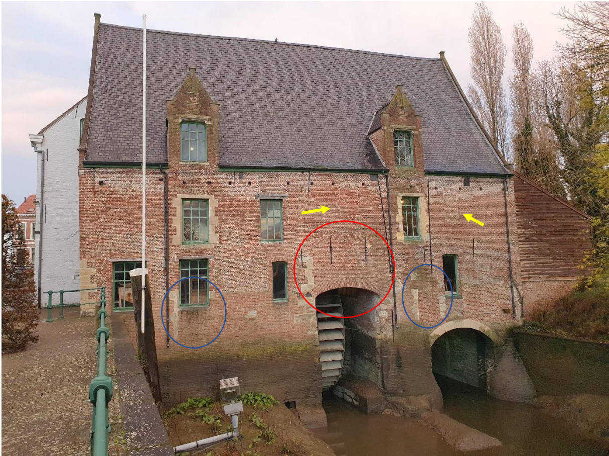
Fig. 76: Overzicht van de zuidgevel. Aanduiding van de originele hoogte van de opening van het waterrad (rood), het oorspronkelijke deur- of vensterniveau onderaan (blauw) en enkele dichtgemaakte vensters (geel).
