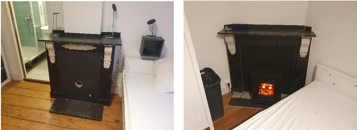
Fig. 166: Sobere houten schouwmantels, waarvan deze in ruimte 1.8 (links) een nieuw bovenblad kreeg.
