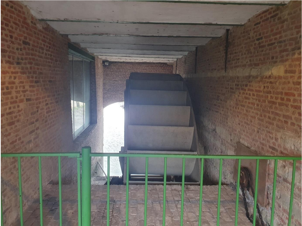
Fig. 95: Overzicht van ruimte 0.2, de radkamer.
