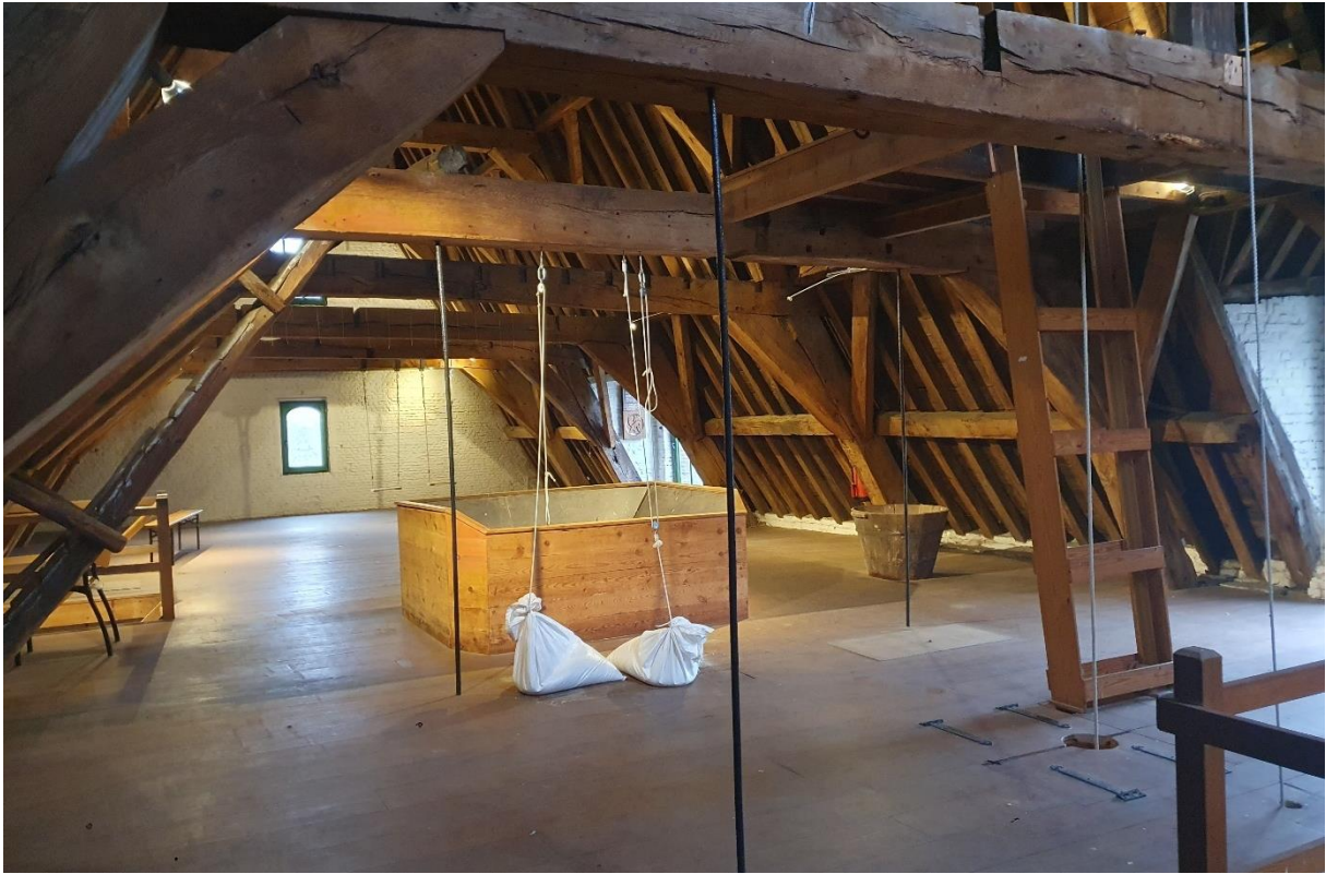
Fig. 140: Overzicht van de zolder.
