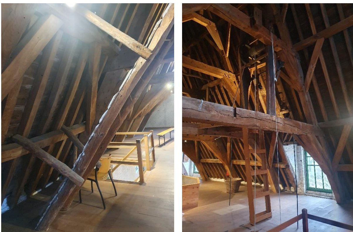
Fig. 147: De houten drager van het verdwenen schouwkanaal (links) en het mechanisme voor het luiwerk (rechts).
