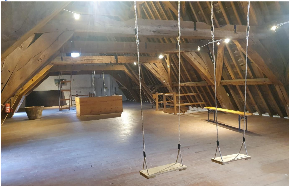
Fig. 141: Overzicht van de zolder.
