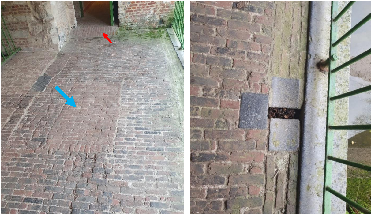
Fig. 97: Links: Dichtgemaakte vloeropening (blauw) in ruimte 0.1, met op de achtergrond het niveauverschil (rood) naar de achterbouw van de molenaarswoning. Rechts: Naast het water een goot met hardstenen afvoer.
