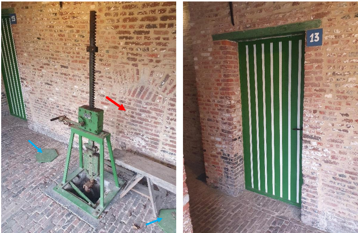
Fig. 98: Links: Recent ophaalsysteem van de vloedsluisdeur, geflankeerd door twee (afgesloten) kokertjes (blauw). Daarachter een dichtgemaakte opening op vloerniveau naar ruimte 0.5 (rood). De afmetingen ervan sluiten uit dat dit een deuropening was, waardoor kan aangenomen worden dat dit een venster was, wat op zijn beurt laat vermoeden dat het vloerniveau van ruimte 0.5 oorspronkelijk lager moet gezeten hebben. Rechts: Rond alle deuren die naar de molen leiden zijn bouwsporen te zien die er op wijzen dat de openingen pas later ingebracht zijn. Al het schrijnwerk werd bij de restauratie vervangen door het huidige.
