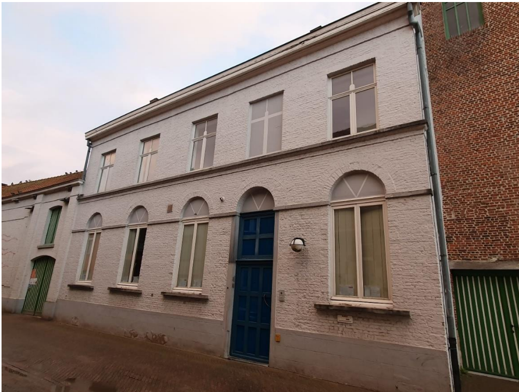
Fig. 84: Westgevel van de molenaarswoning.
