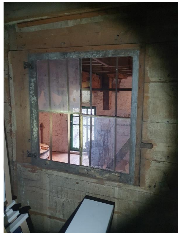
Fig. 126: In het hok is het enige historische schrijnwerk van het hele gebouw bewaard gebleven, waarbij een midden-19 de -eeuwse datering zeker kan kloppen. Het deurtje gaf uit op ruimte 1.5 van de molenaarswoning, maar de deuropening werd inmiddels dichtgemaakt. De doorgang naar ruimte 1.6 is wel nog functioneel, maar ingevuld met een nieuwe deur.
