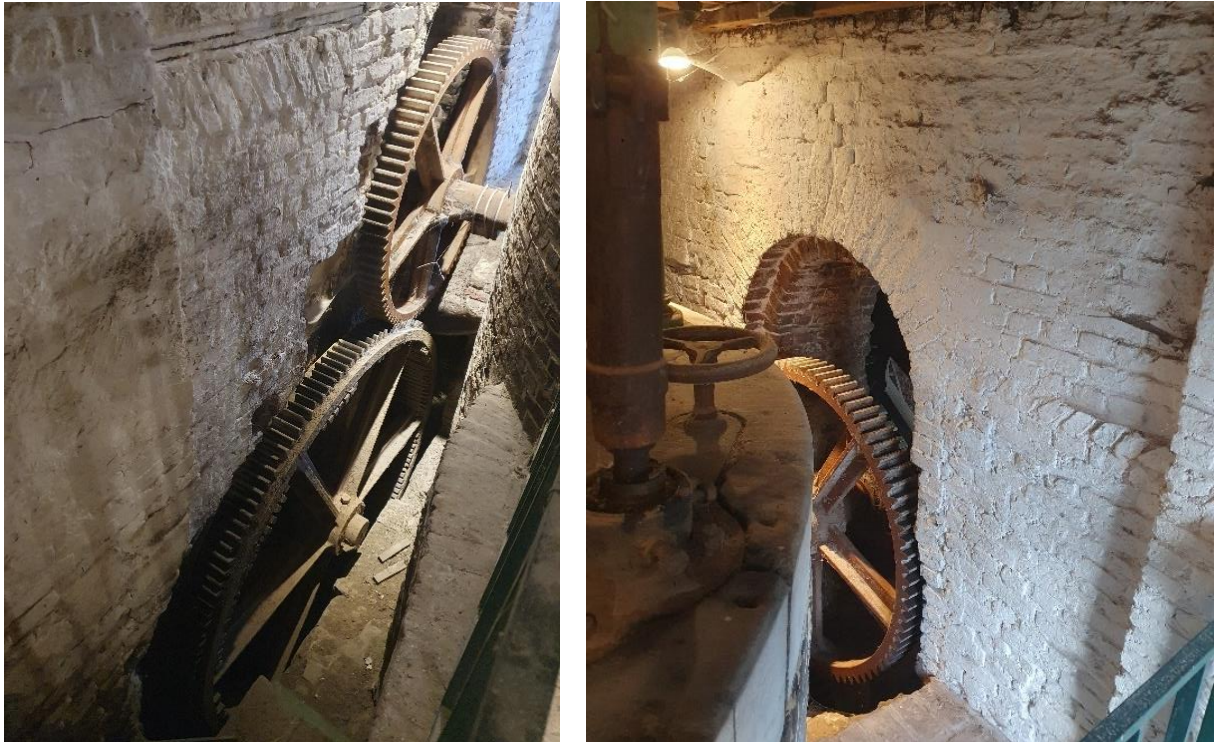
Fig. 112: Aan de oostzijde leidt een trapje naar een verdiept vloerniveau, waar de wand opengeboren werd om het waterwiel te laten indraaien op het bovenliggende wiel. Vermoedelijk was dit het oorspronkelijke vloerniveau aangezien dit zou overeenkomen met de dichtgemaakte vensters die nog in de zuidgevel en ruimte 0.2 te zien zijn (links). De bovenste rondboogopening laat zien dat het voorgaande systeem een kleiner wiel had dat hier in draaide (rechts).
