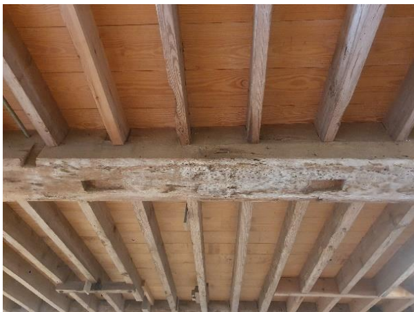
Fig. 137: Inkepingen van een verdwenen standvink bij een van de moerbalken (links). Naast het zoldertrapje kan aan de raveel het voormalige trapgat afgelezen worden (rechts).
