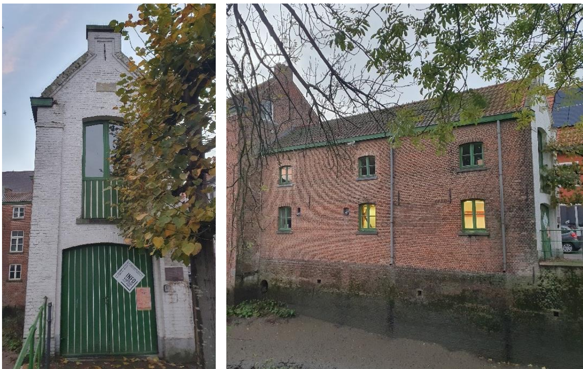
Fig. 90: Noord- (links) en oostgevel (rechts) van de brandweerkazerne.
