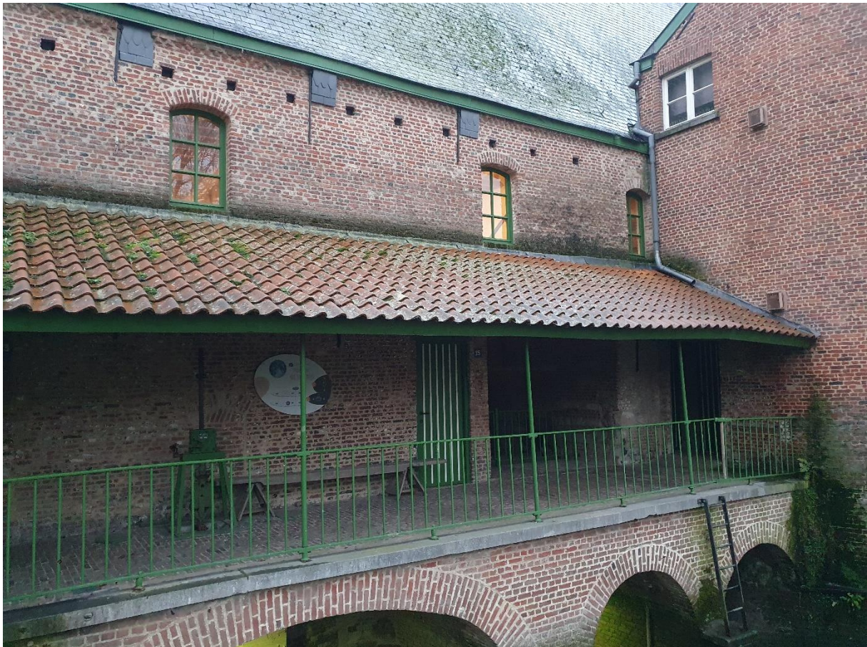
Fig. 82: Overzicht van de noordelijke gaanderij. Hier was oorspronkelijk een houten brug aanwezig die later versteende en overdekt werd. De huidige overkapping werd volledig heropgebouwd bij de restauratie.
