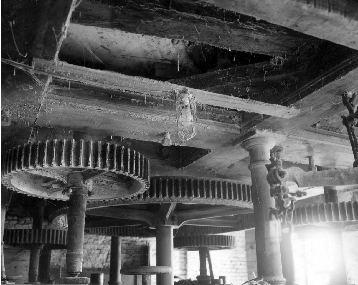
Fig. 29: Foto van het maalwerk uit 1945. (Balat, KIK-IRPA, b089178.)
