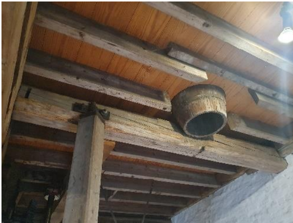
Fig. 130: Trechters in de plafond waarlangs het graan in de onderliggende karen werd gestort, er zijn slechts twee van de vier nog aanwezig, en elk van een ander type.
