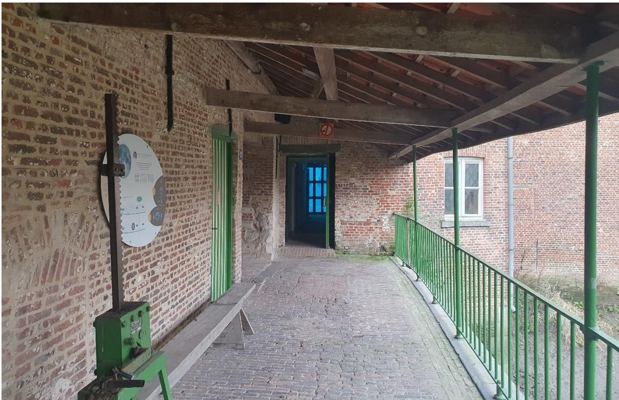
Fig. 94: Overzicht van ruimte 0.1.
