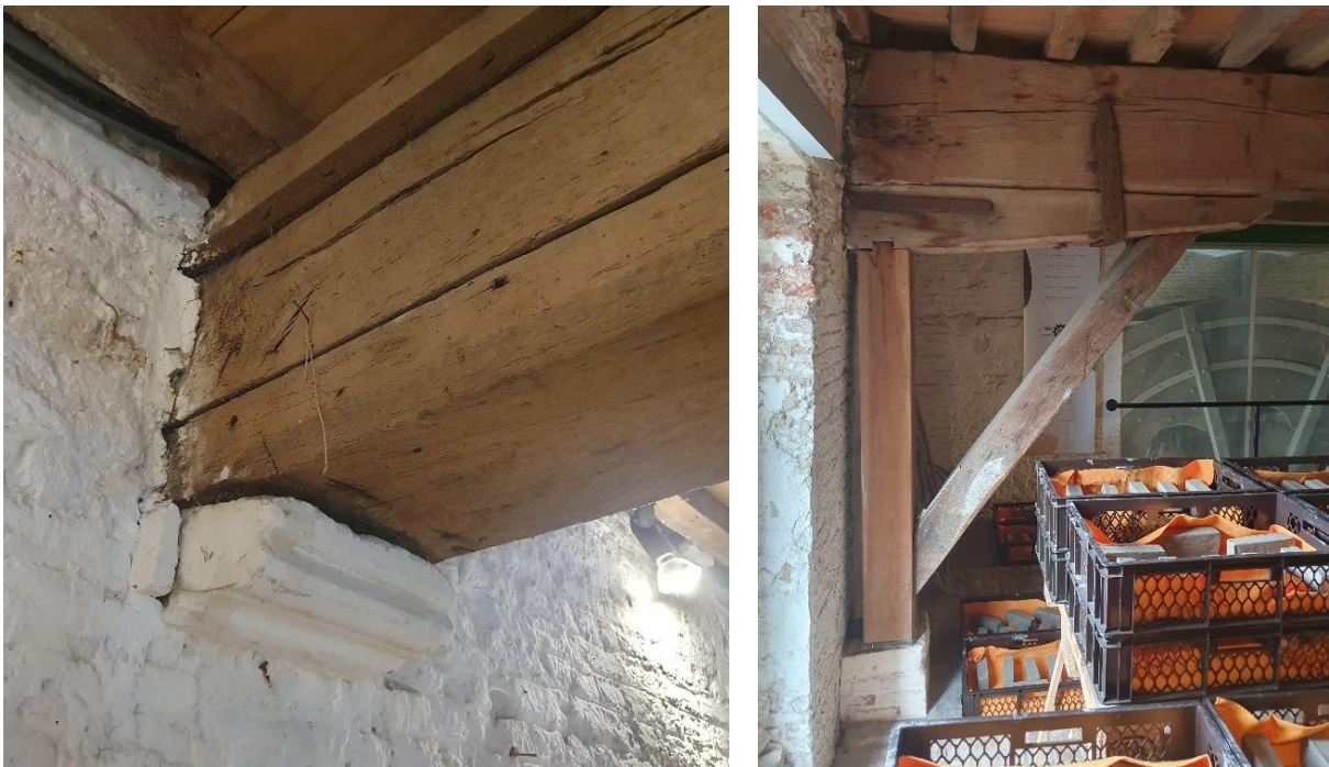
Fig. 118: Oplegging van de moerbalken op consoles met peerkraalprofilering, een typisch 16 de -eeuwse uitwerking (links). Een van de moerbalken werd langs de zuidzijde versterkt door een balkslof op een stijl en korbeel te bevestigen (rechts).
