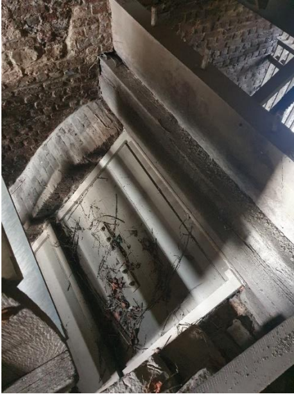
Fig. 103: De sluisdeur is schuin geplaatst (links) en kan open en dicht gezet worden met de ketting die door het gewelf steekt (rechts).
