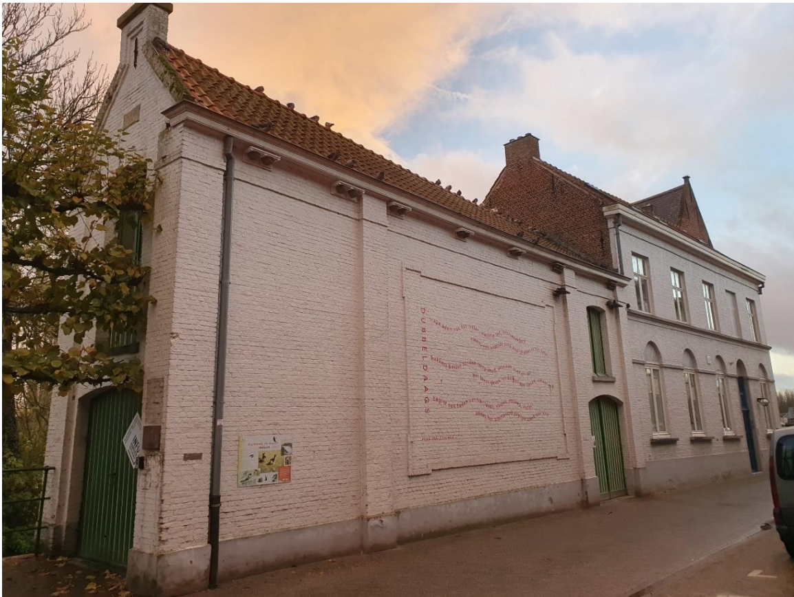
Fig. 89: Westgevel van de brandweerkazerne.
