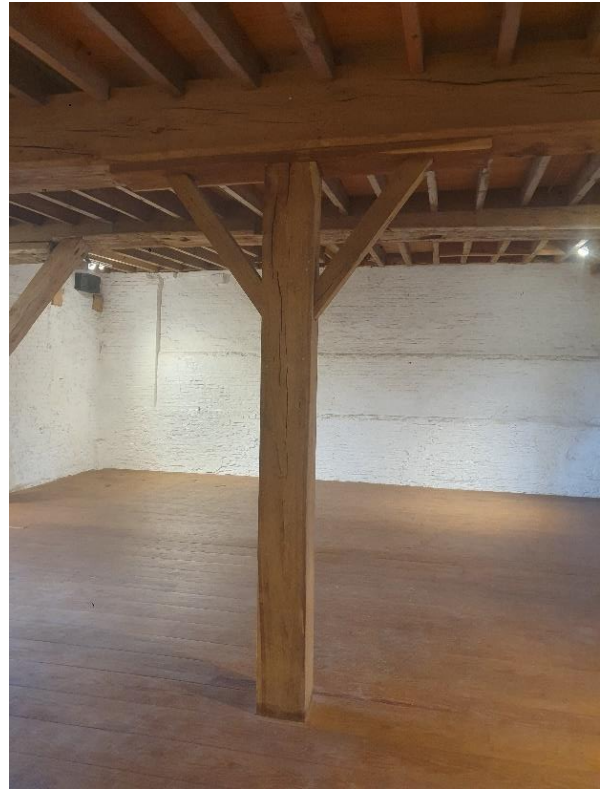
Fig. 136: Verstevingen aangebracht om de verzakking van de balkkoppen op te vangen.
