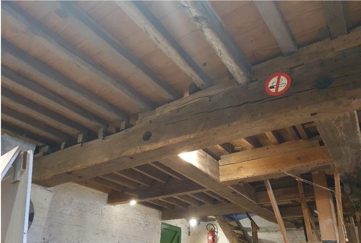
Fig. 110: De balken vertonen vele inkepingen en andere bouwsporen, er op wijzend dat de inrichting en maalsysteem dat hieraan verankerd zat reeds verschillende keren aangepast werd. Ook de kinderbalken moeten zich tijdens een voorgaande periode lager bevonden hebben, gezien de aanwezigheid van de loefgaten in de moerbalk.
