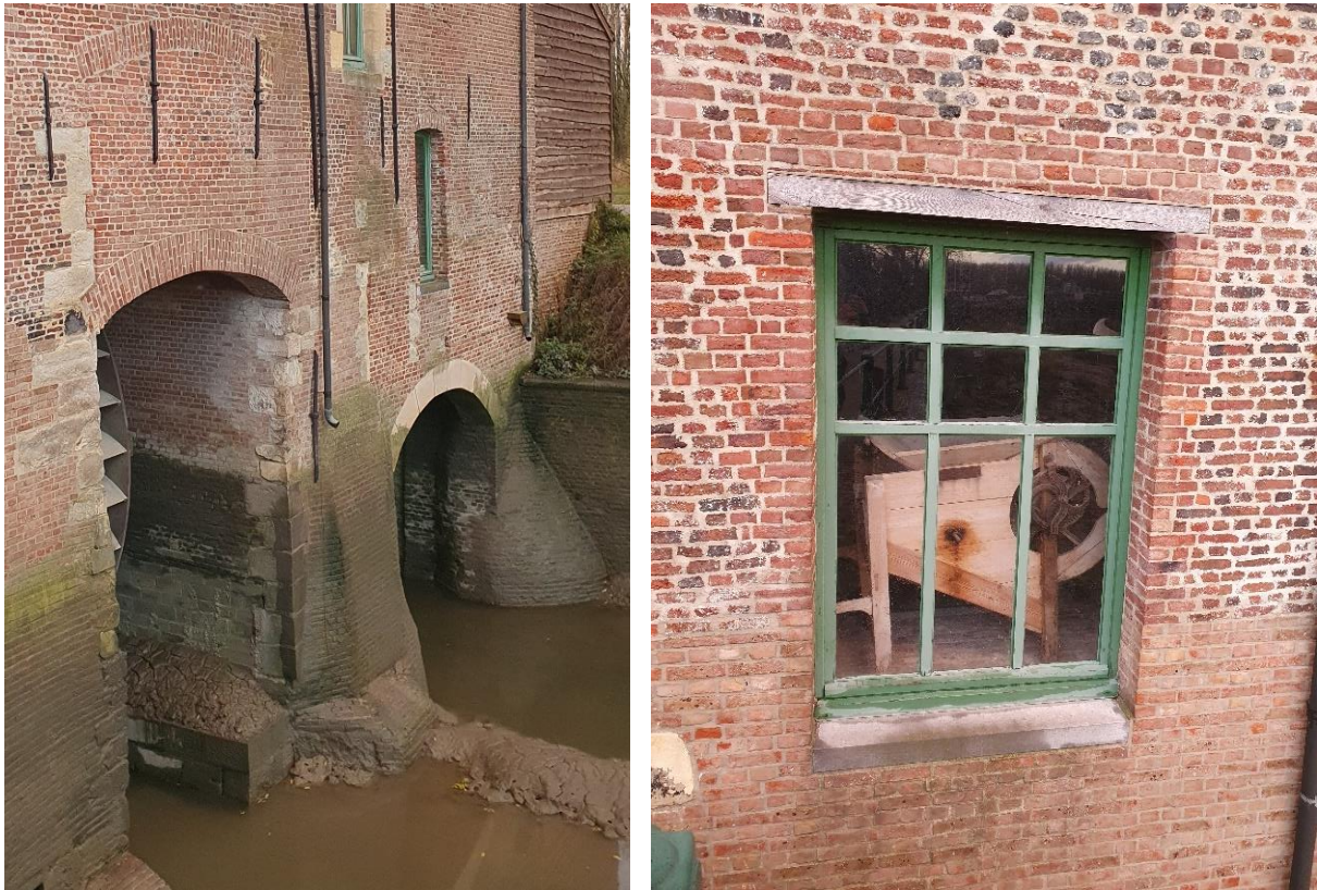
Fig. 80: Detail van de openingen voor waterrad en getijdensluis, de wanden worden breder naar beneden toe (links) en voorbeeld van een venster met postmodern raam. Aan het afwijkende baksteenmetselwerk rondom het venster kan gezien worden dat dit pas later toegevoegd werd (rechts).
