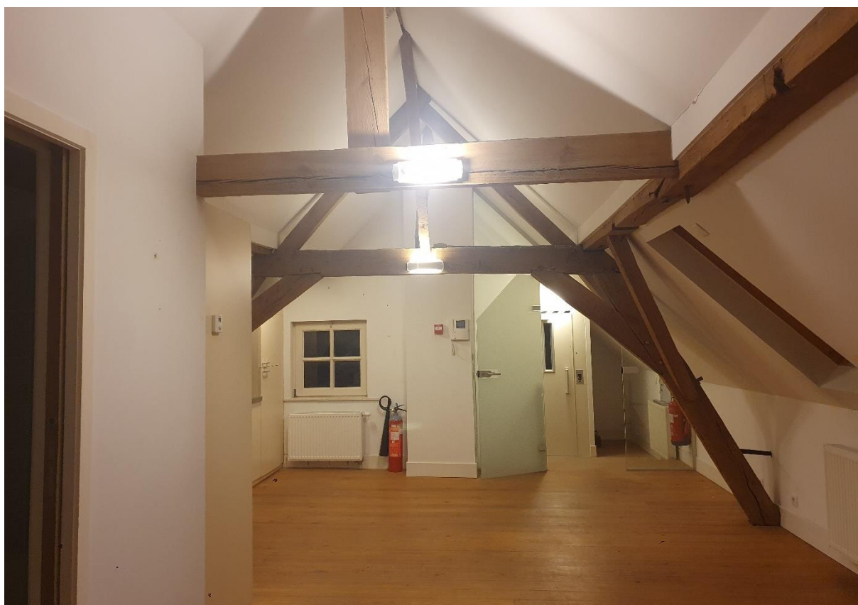
Fig. 171: Overzicht van ruimte 2.3.
