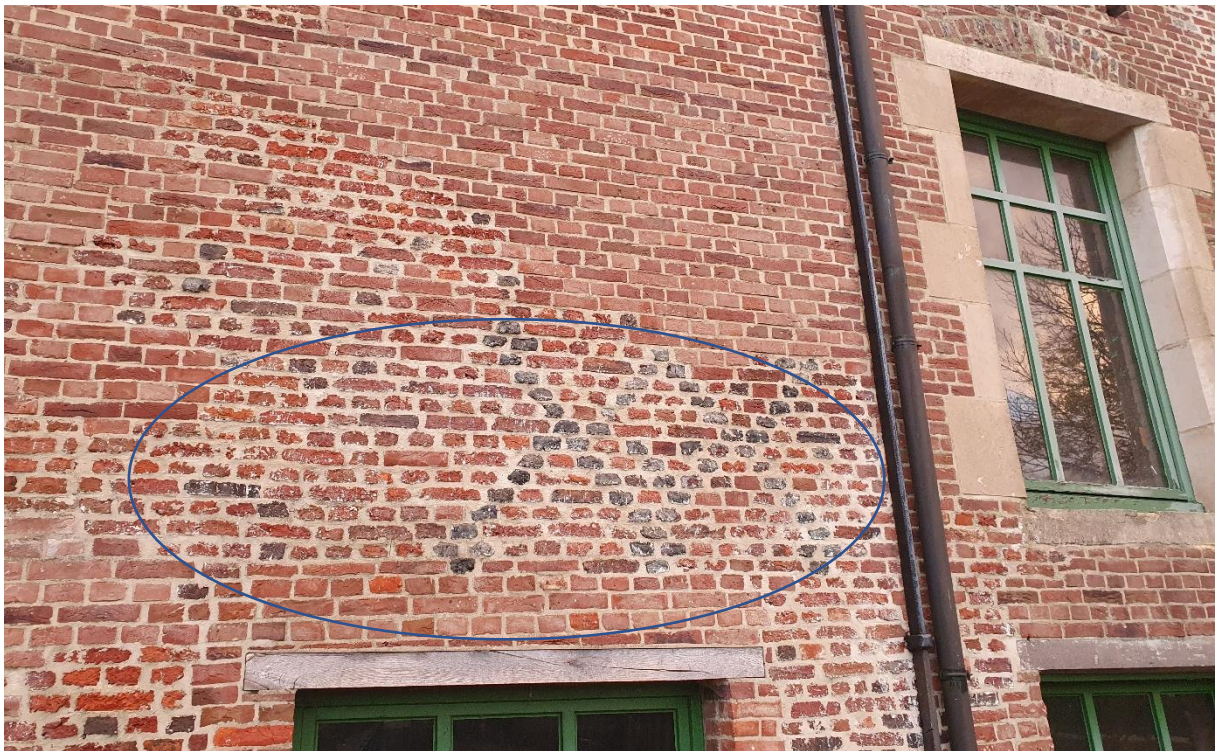
Fig. 79: Aanduiding van de naast elkaar gelegen kruisvormen in het parement van de zuidgevel, gevormd door gesmoorde bakstenen. De gevel moet oorspronkelijk dus volledig van siermetselwerk voorzien geweest zijn. Het feit dat dit heden enkel nog ter hoogte van deze kleine gevelzone aanwezig is maakt duidelijk in welke mate het gevelparement door de jaren heen vervangen werd. De negblokken van het venster rechts daarvan zijn een vervanging van de oude exemplaren bij de restauratie van de jaren 1990.
