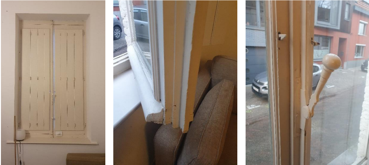
Fig. 160: Ramen met gesloten recente binnenluiken (links), de sluiting en opgelegde glaslatten langs buiten om bij de restauratie van de jaren 1990 dubbel glas te kunnen plaatsen (midden) en spanjolet met hendel als sluitsysteem, waarboven ingebouwde haakjes om de binnenluiken vast te zetten (rechts). Deze haakjes wijzen er op dat de ramen oorspronkelijk reeds van binnenluiken voorzien waren.
