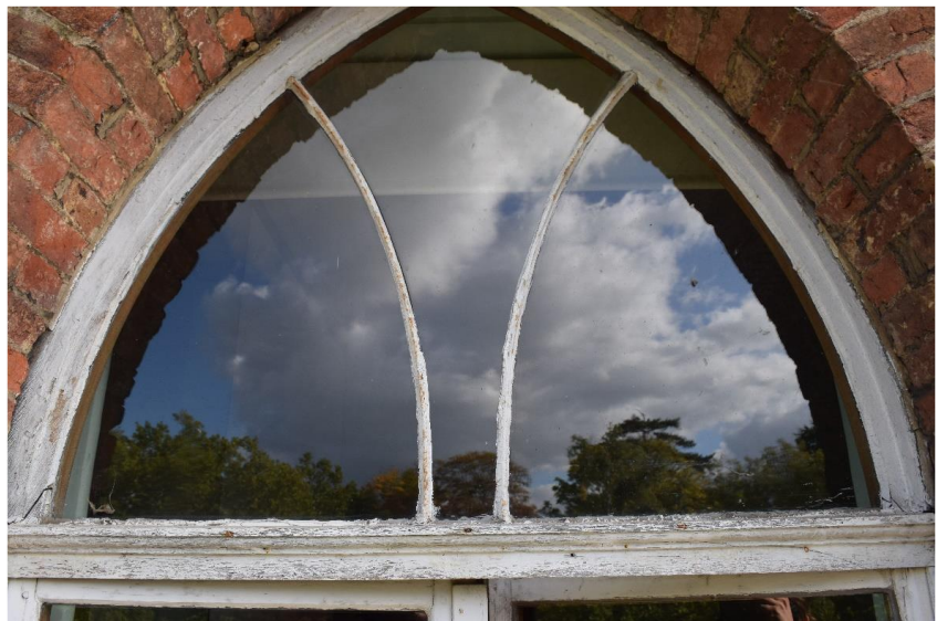
Fig. 86: Interieurzicht van het begin 19de-eeuws houten raam (type 2) op de derde verdieping (links), met detail van het bovenlicht (rechts). (Foto's van Anneleen Cassiman)
