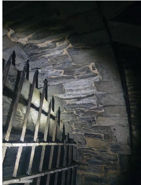
Fig. 97: Ruimtes -1.2 en -1.3 worden afgescheiden door een ijzeren hek (links). De boog als overgang tussen ruimte -1.1 met -1.2 en -1.3 heeft vlak afgewerkte hoekkettingen, opgevuld met breuksteenmetselwerk daartussen (rechts).
