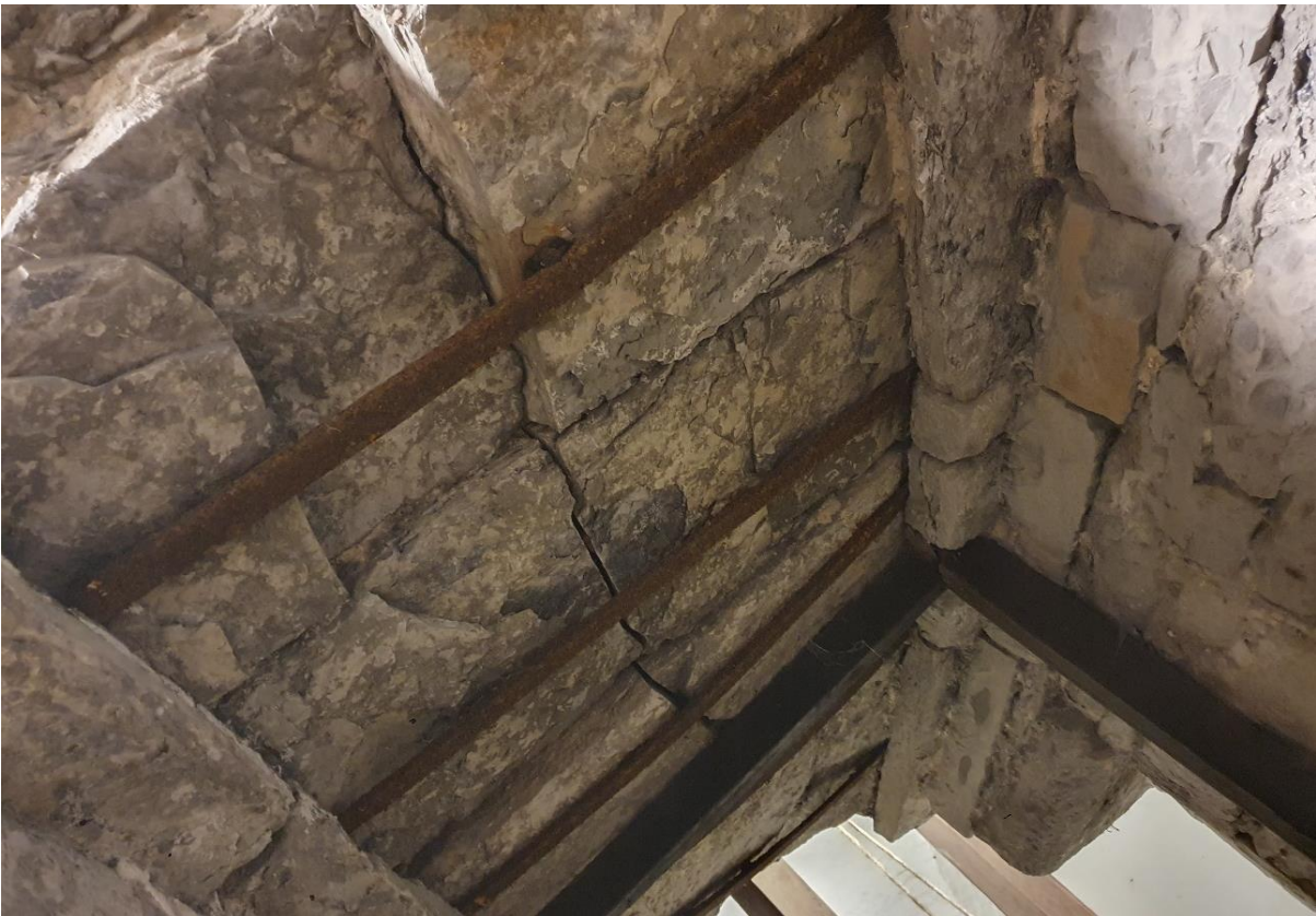
Fig. 106: Overspanning van de deuropening naar ruimte 0.2, met grote dekstenen, kraagstenen langs weerszijden en versteiging met trekijzers.
