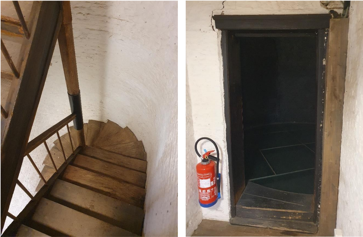
Fig. 132: Overzicht van de draaiende traparm (links) en houten deuromlijsting naar ruimte 3.2.
