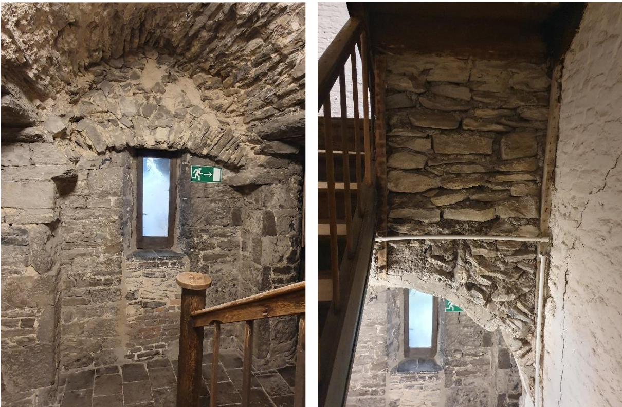
Fig. 108: In de westmuur werd een schietgleuf verkleind tot klein venster met houten raam boven een dichtgemetselde borstwering (links). Aanzicht van de zijkant van het tongewelf (rechts).
