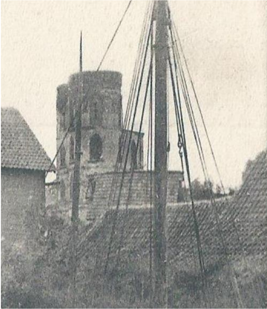
Fig. 45: Detail van een postkaart, afgestempeld in 1902. Op de bovenste verdieping werden al vensteropeningen dichtgemetseld. (DELCAMPE, Postkaarten.)
