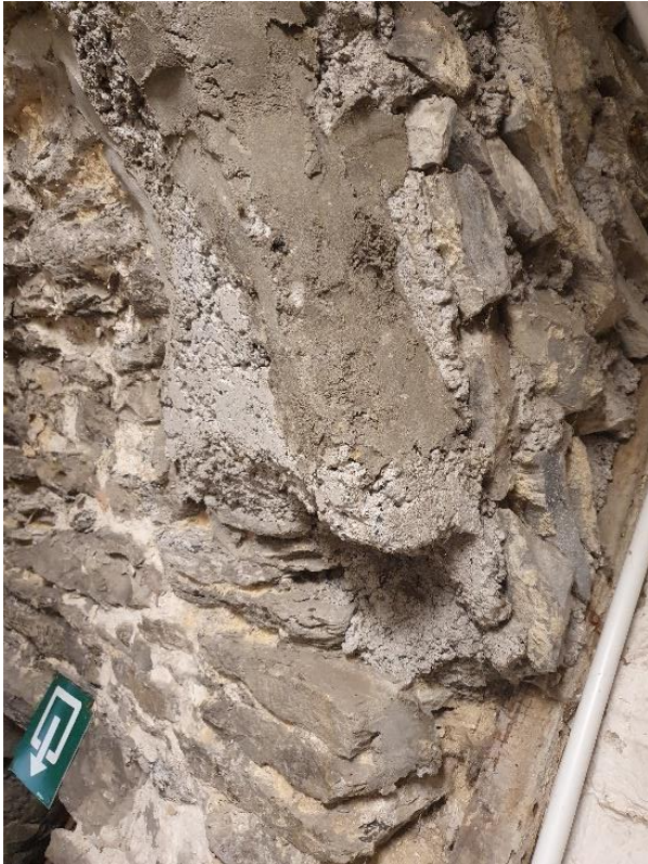
Fig. 109: Het gewelf werd plaatselijk aangewerkt met cement (links). Het is duidelijk te zien waar de middeleeuwse courtine stopte en vanaf waar in de 19 de eeuw werd verdergebouwd met baksteen (rechts).
