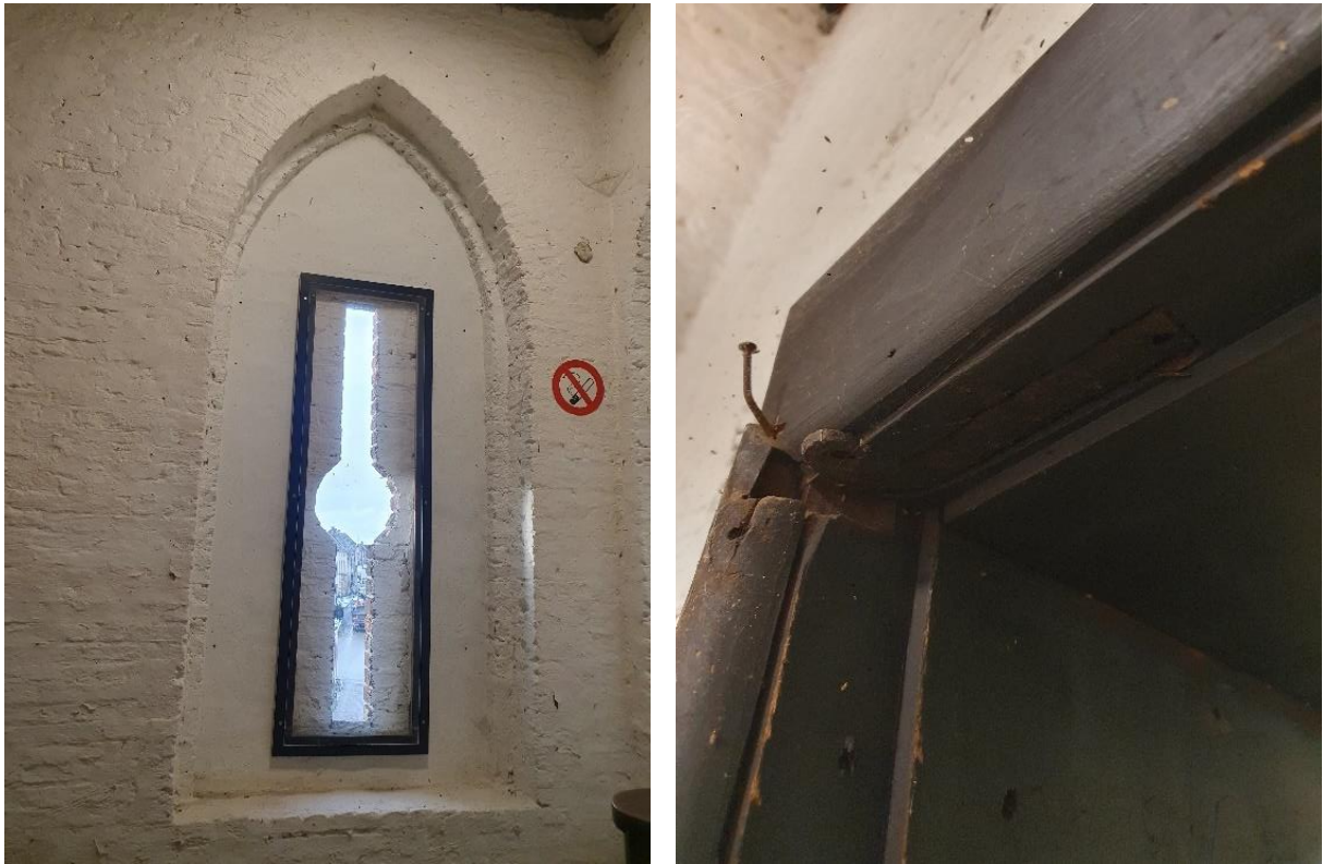
Fig. 127: Dichtgemaakt spitsboogvenster met schietgleuf, waarvoor voorzetbeglazing (links) en de taatspot in de deuromlijsting laat een vroeg-19 de -eeuwse datering vermoeden (rechts).
