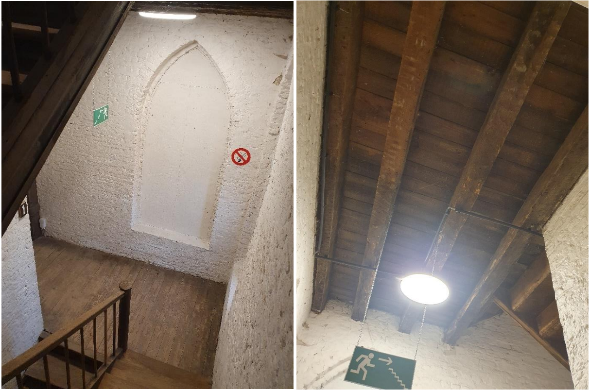
Fig. 119: Dichtgemaakt spitsboogvenster (links) en houten roosting (rechts).
