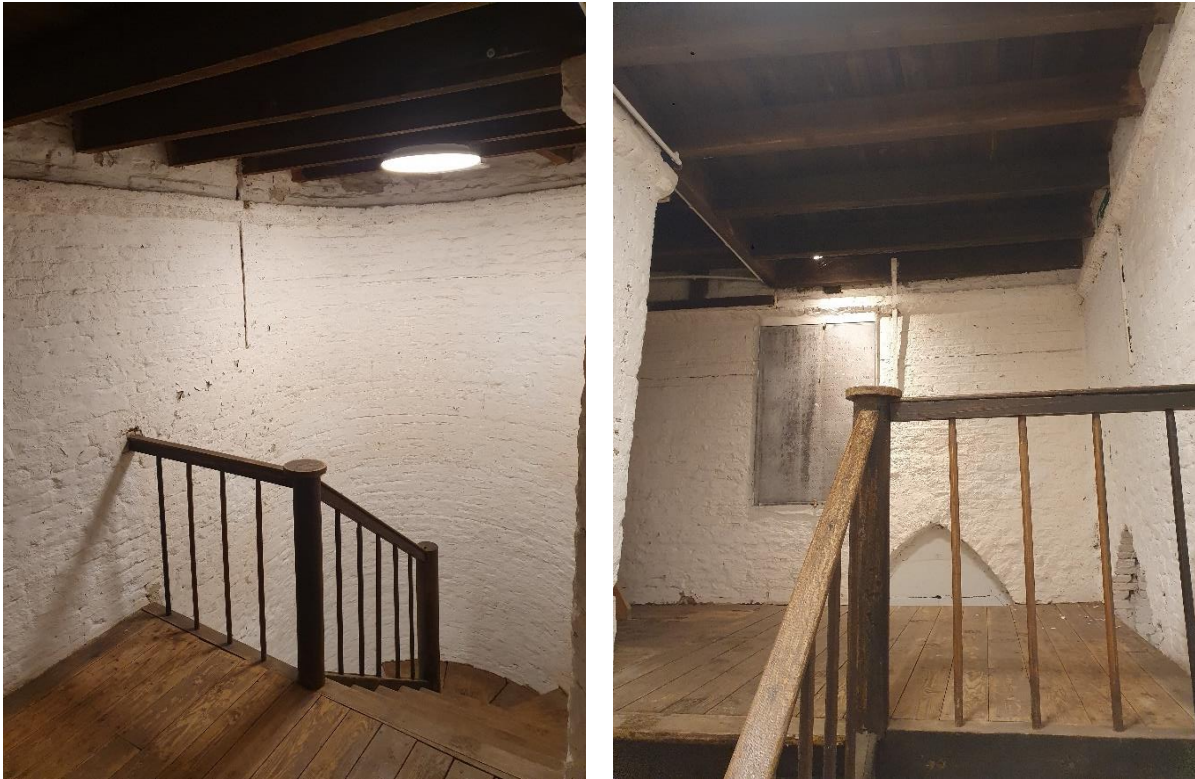
Fig. 135: Overzicht van ruimte 4.1.
