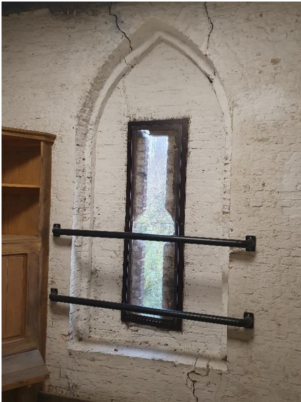
Fig. 123: Recent dichtgemaakt spitsboogvenster, met buisbalustrade (links) en open haard met flankerende nissen (rechts).
