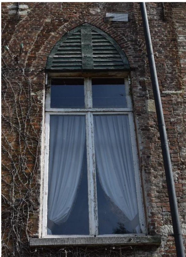
Fig. 88: Exterieurzicht van het begin 19de-eeuws houten raam (type 3) op de tweede verdieping (links) en interieurzicht ervan (rechts).
