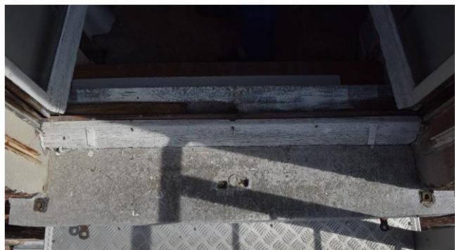
Fig. 89: Detail van de blauwe hardstenen latei tussen het raam (type 3) en het blind 'bovenlicht' (links), en detail van de blauwe hardstenen dorpel met sporen van de luiken (rechts).
