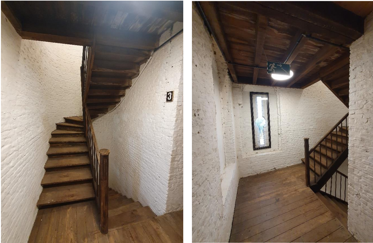
Fig. 131: Overzicht van ruimte 3.1.
