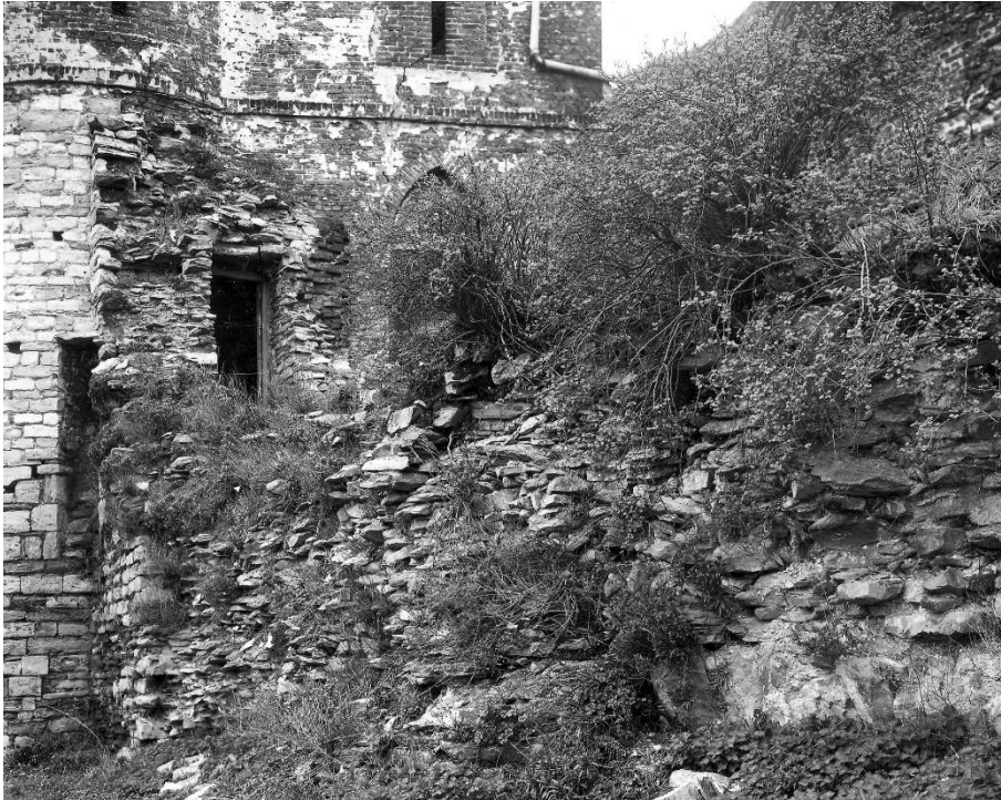
Fig. 56: Foto uit 1945 van de achtergevel van de Graventoren en de verbindingsmuur. (BALAT KIK-IRPA, b089162.)
