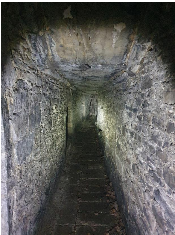
Fig. 92: Overzicht van het centrale gedeelte van ruimte -1.1.
