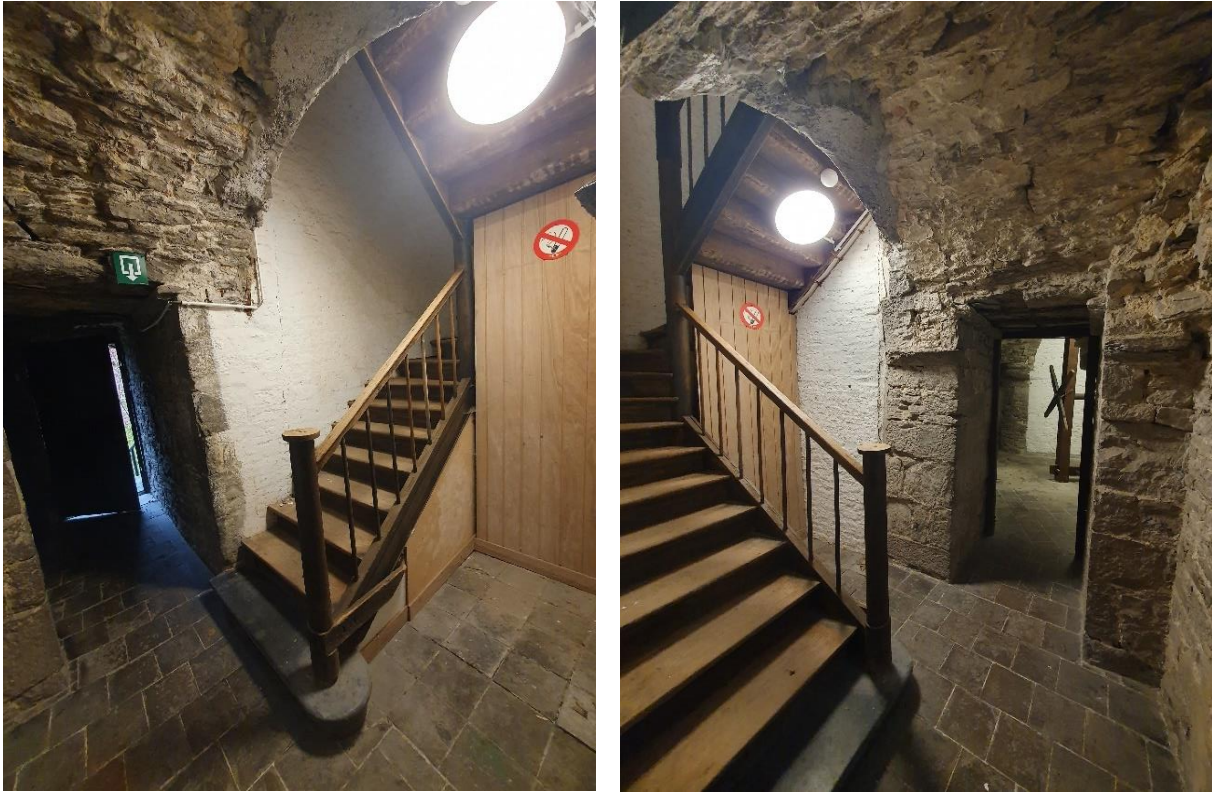
Fig. 107: Overzicht van ruimte 0.2.
