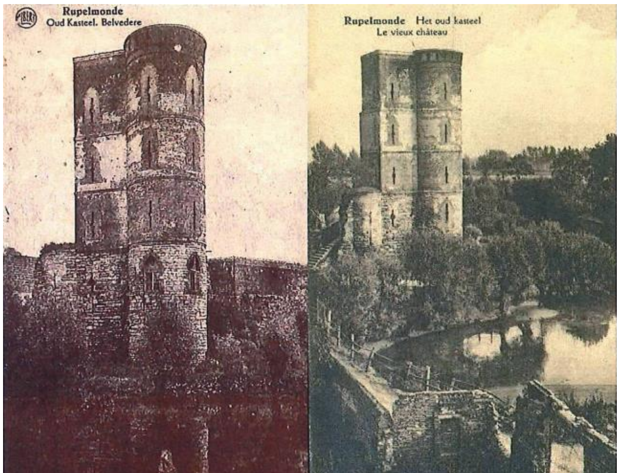
Fig. 53: Postkaarten van de Graventoren van circa 1923 en 1930. Links met raaminvulling, rechts dichtgemetselde vensteropeningen. (AMEDEE VERBRUGGENKRING-RUPELMONDE, Rupelmonde , 1975, 64. En DELCAMPE, Postkaarten, poststempel 1931.)
