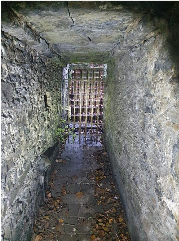
Fig. 91: Overzicht van het zuidelijke gedeelte van ruimte -1.1.
