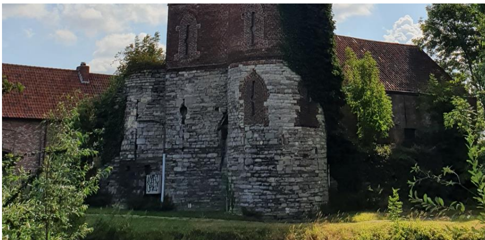
Fig. 10: De onderbouw van de huidige Graventoren in Doornikse kalksteen dateert uit circa 1254.
