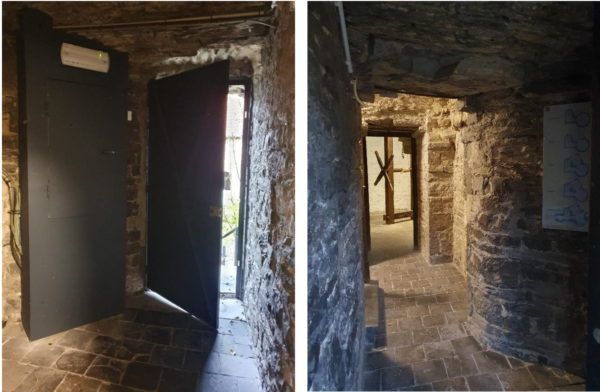
Fig. 104: Overzicht van ruimte 0.1.
