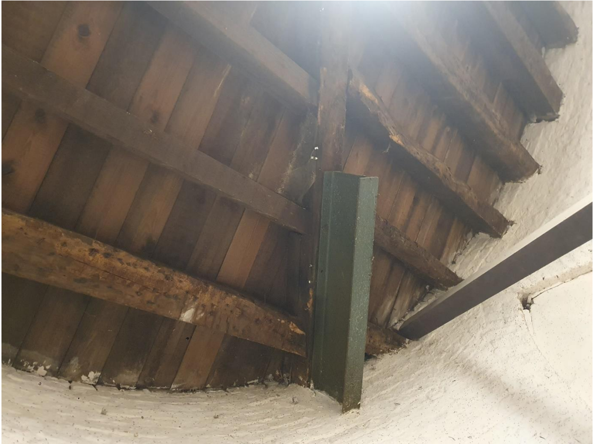
Fig. 121: De houten roostering wordt plaatselijk ondersteund door een uitkragende stalen ligger.
