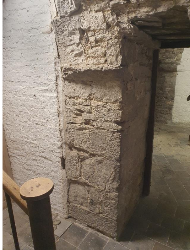
Fig. 109: Het gewelf werd plaatselijk aangewerkt met cement (links). Het is duidelijk te zien waar de middeleeuwse courtine stopte en vanaf waar in de 19 de eeuw werd verdergebouwd met baksteen (rechts).
