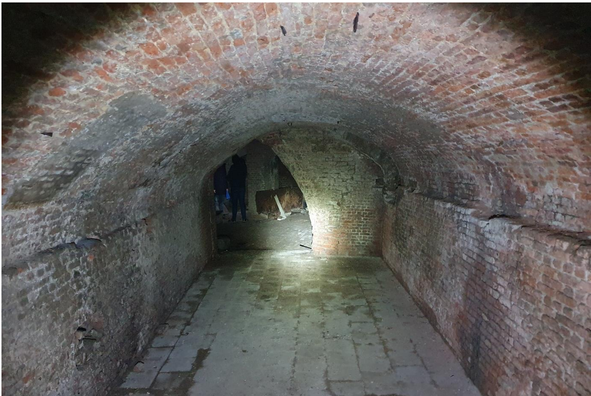
Fig. 101: Overzicht van ruimte -1.5.
