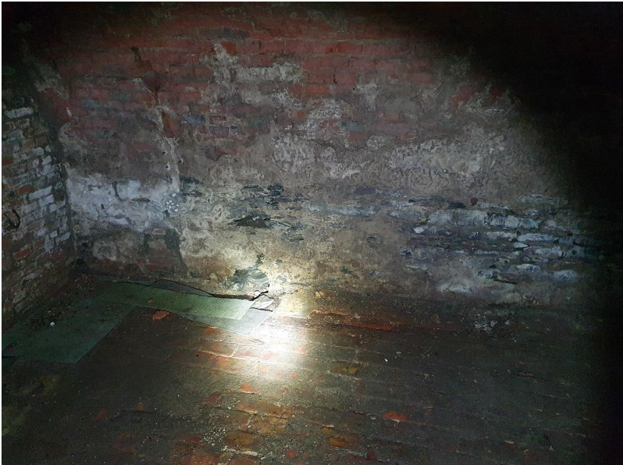
Fig. 102: De onderzijde van de westwand van ruimte -1.4 betreft de oude burchtmuur die als basis voor het bakstenen keldergewelf werd gebruikt.
