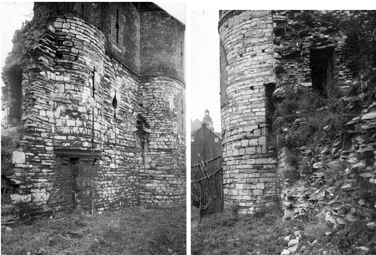
Fig. 57: Foto's uit 1945. Links: Zicht op de voor- en zijgevel van de benedenverdieping van de Graventoren. Rechts: Hoektoren. (BALAT KIK-IRPA, b089158 en b089163.)
