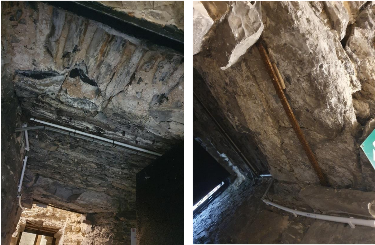
Fig. 105: Overzicht van de plafond, bestaande uit een gedrukt gewelf (links) en overspanning boven de deuropening in de buitenwand, met deksteen versteigd door een trekijzer (rechts).
