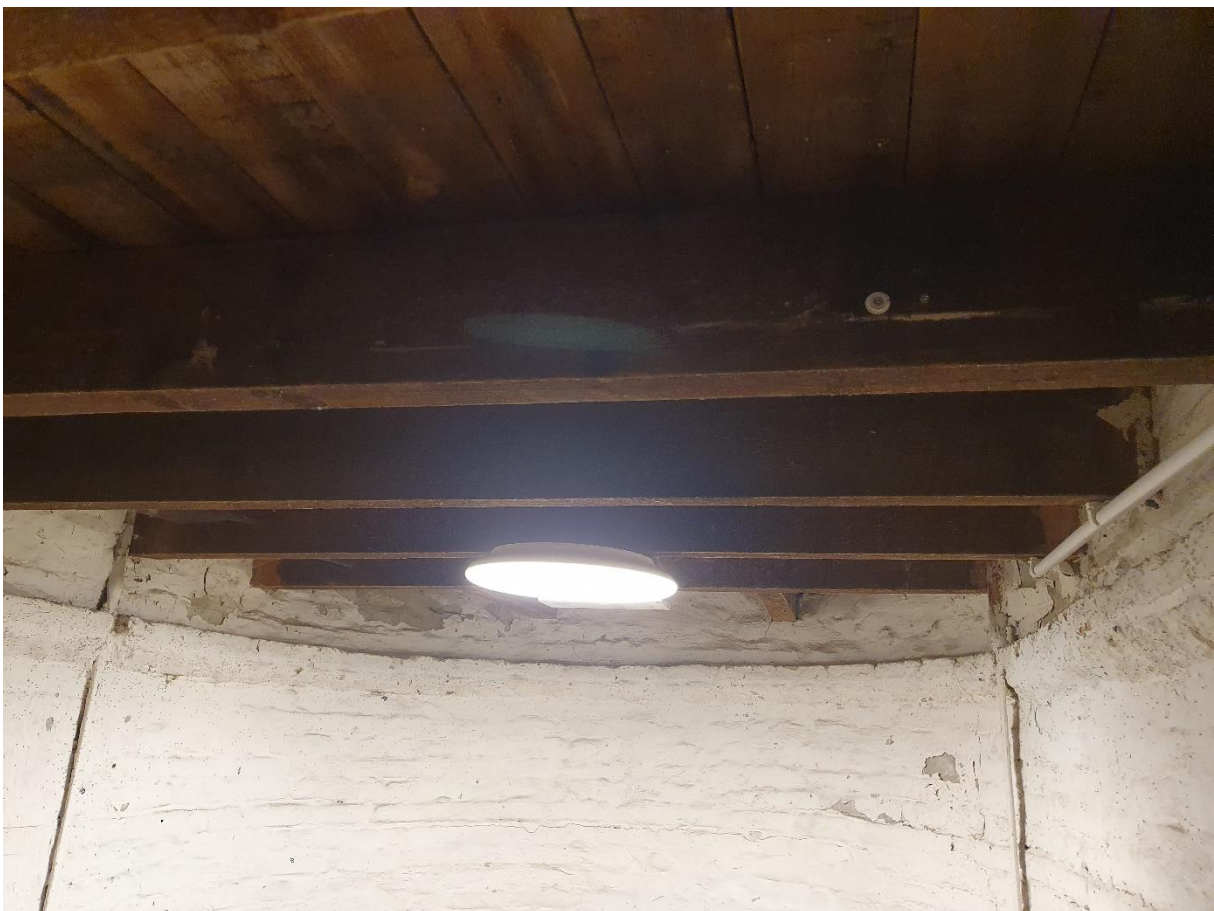
Fig. 137: Plafondroostering met daaronder een bakstenen lijst die het oorspronkelijke plafondniveau aangeeft.
