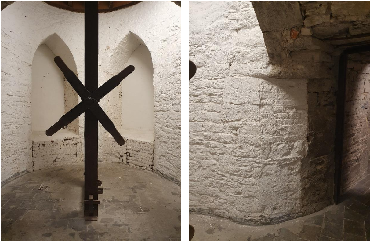
Fig. 111: De inmiddels dichtgemaakte spitsboogvensters zijn binnen de Doornikse kalksteenwanden uitgewerkt met baksteeninvulmetselwerk (links). In beide oksels tussen de ronde toren en courtine zit een dichtgemaakte opening, deze gaven uit op de latrines die buiten nog te zien zijn (rechts).
