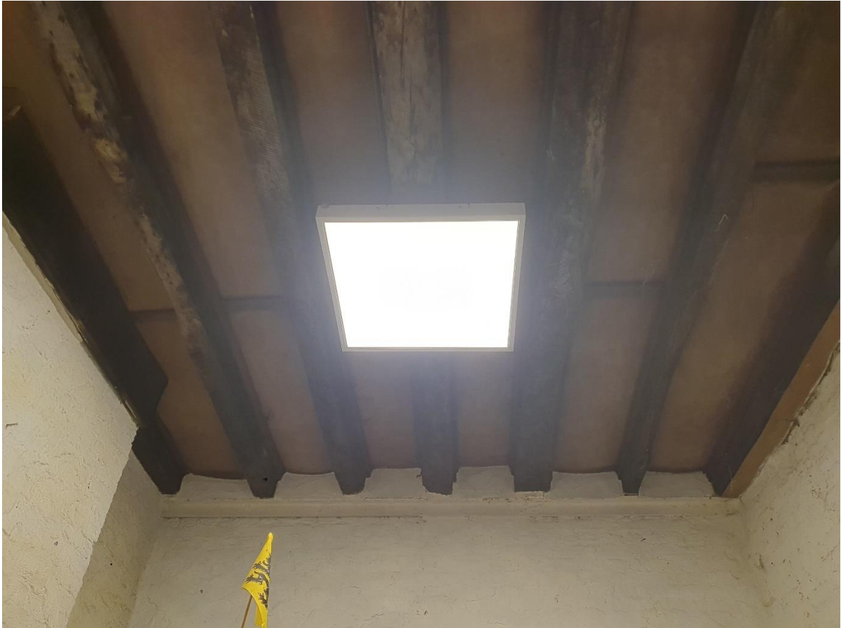
Fig. 116: Overzicht van de houten roostering.
