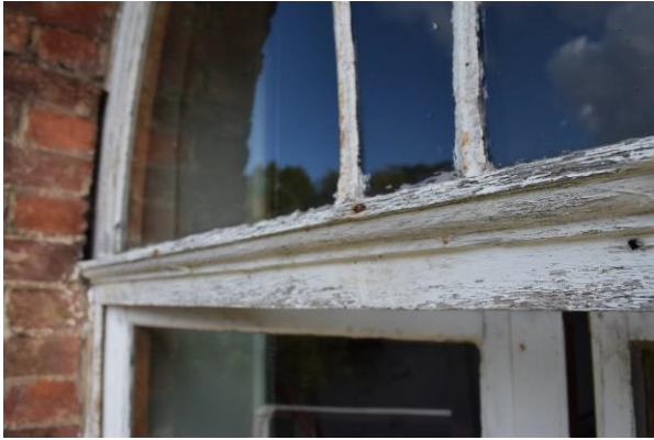
Fig. 87: Detail van de geprofileerde regel tussen het bovenlicht en de twee opendraaiende vleugels van het begin 19de-eeuws houten raam op de derde verdieping (links) en detail van de blauwe hardstenen vensterdorpel met sporen van de luiken (rechts). (Foto's van Anneleen Cassiman)
