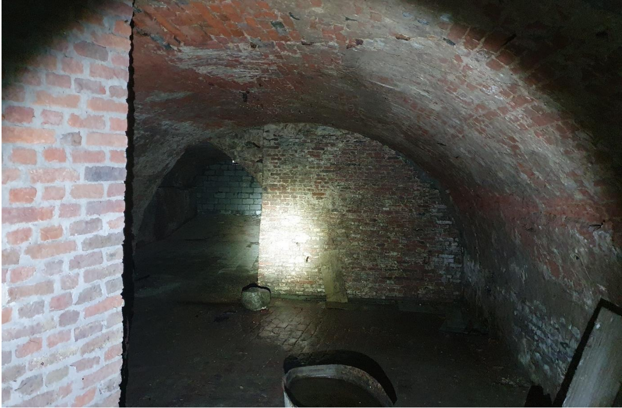
Fig. 100: Overzicht van ruimte -1.4.
