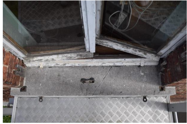
Fig. 87: Detail van de geprofileerde regel tussen het bovenlicht en de twee opendraaiende vleugels van het begin 19de-eeuws houten raam op de derde verdieping (links) en detail van de blauwe hardstenen vensterdorpel met sporen van de luiken (rechts). (Foto's van Anneleen Cassiman)
