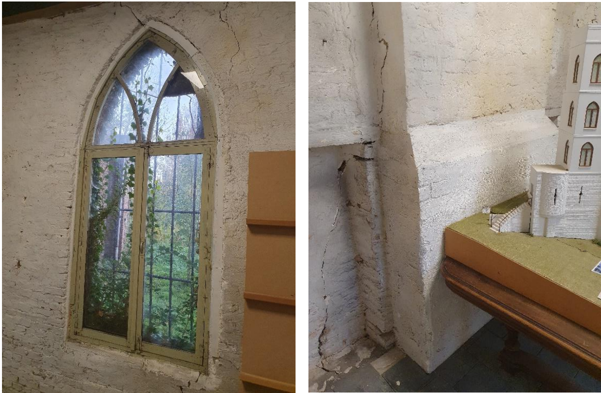
Fig. 114: 20 ste -eeuws spitsboograam, gemaakt naar historisch model (links) en schouwvolume tegen de oostwand (rechts).
