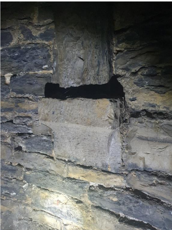
Fig. 98: De ribben van ruimtes -1.2 en -1.3 rusten op Romeinse consoles (links). In de ruimtes zijn telkens 3 half ingegraven schietgleuven aanwezig (rechts).
