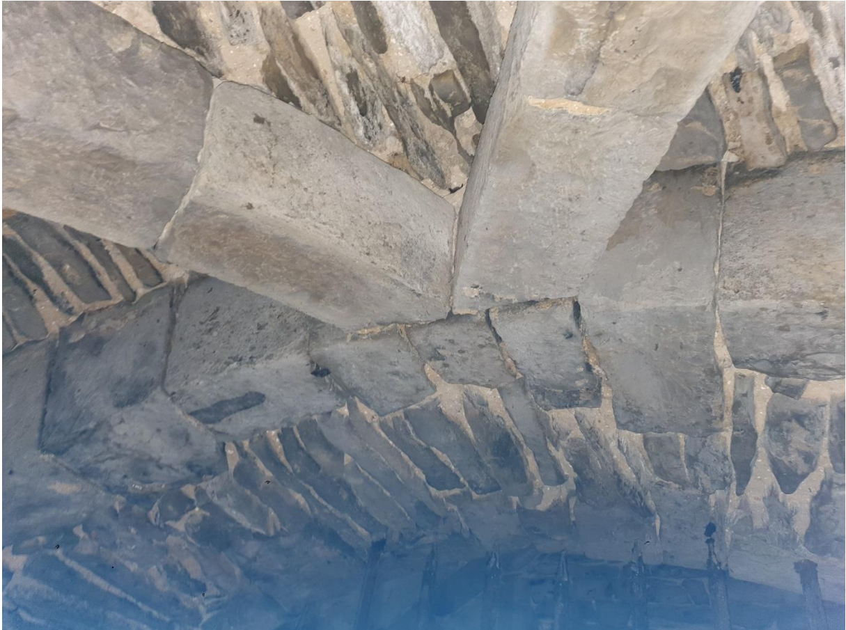
Fig. 99: Detail van de aansluiting van de ribben op de scheidingsboog met ruimte -1.1. Het gewelf zelf is opgebouwd uit breuksteen.
