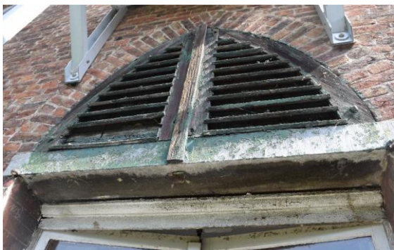
Fig. 89: Detail van de blauwe hardstenen latei tussen het raam (type 3) en het blind 'bovenlicht' (links), en detail van de blauwe hardstenen dorpel met sporen van de luiken (rechts).
