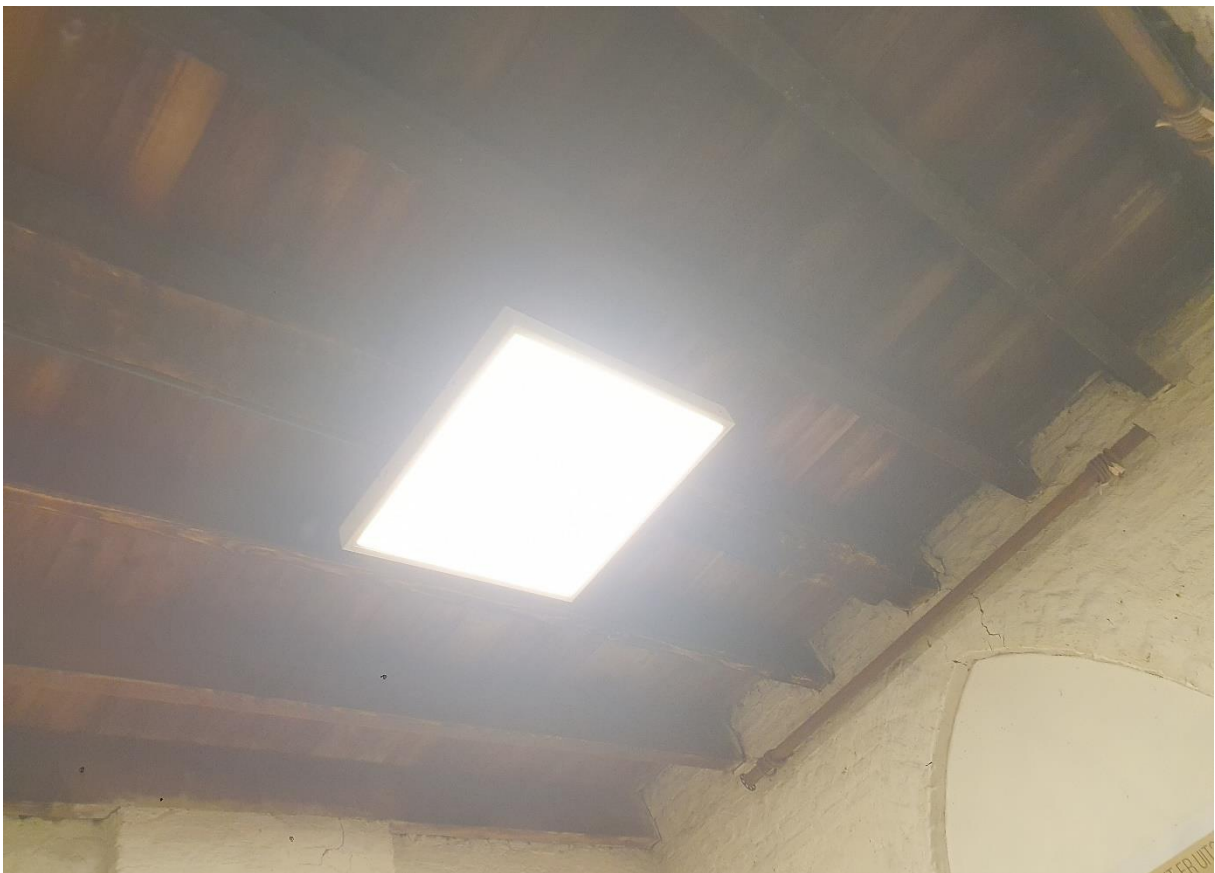
Fig. 124: Overzicht van de houten roostering, met centraal de gerecupereerde balk.
