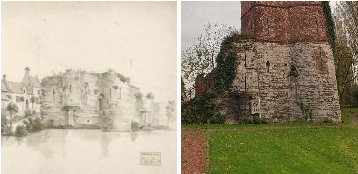
Fig. 141: Vergelijking tussen de tekening uit 1722 en de huidige toestand laat enerzijds zien hoe correct de tekening opgesteld werd, en anderzijds dat de huidige halfondergrondse rondgang zich destijds ook al op dit niveau bevond. Er moet dus door de eeuwen heen een wijziging aan het waterniveau van de omgrachting plaatsgevonden hebben aangezien de rondgang bij de waterstand die te zien is in 1722 permanent onder water moet gestaan hebben.
