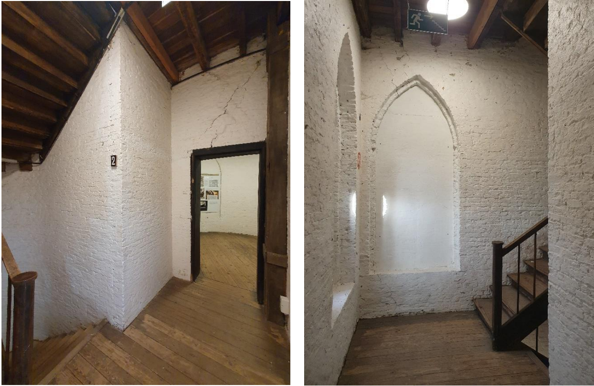
Fig. 126: Overzicht van ruimte 2.1.
