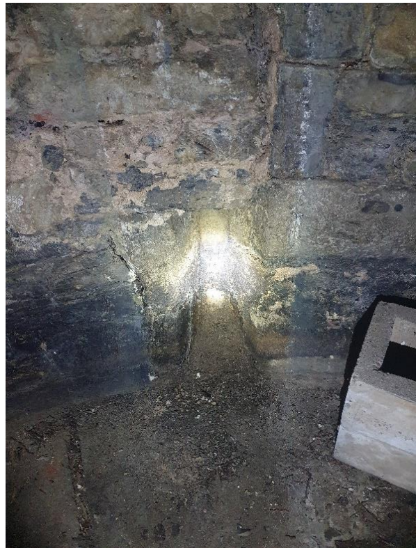
Fig. 98: De ribben van ruimtes -1.2 en -1.3 rusten op Romeinse consoles (links). In de ruimtes zijn telkens 3 half ingegraven schietgleuven aanwezig (rechts).
